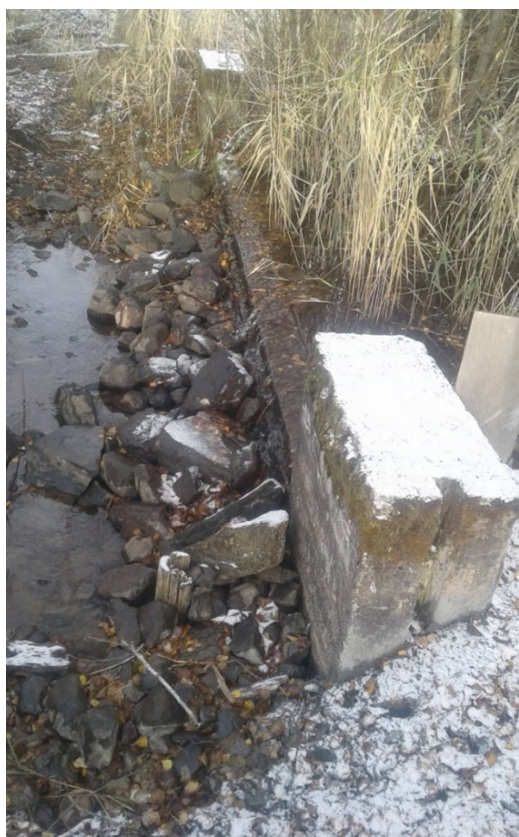
Kuva 11. Pato lokakuussa 2018. Lasku-uomanpuoleinen kiviverhous on nähtävissä veden ollessa alhaalla.
