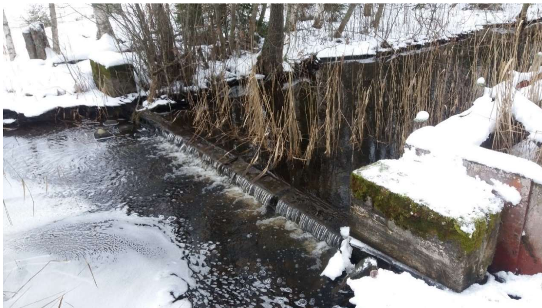
Kuva 10. Pato helmikuussa 2018 eteläpuoleltakatsottuna. Padon puinen harjaosa on vain hieman lasku-uoman vedenpinnan yläpuolella
