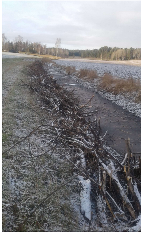
Kuva 31. Liikakasvustosta raivattu lasku- uoma
