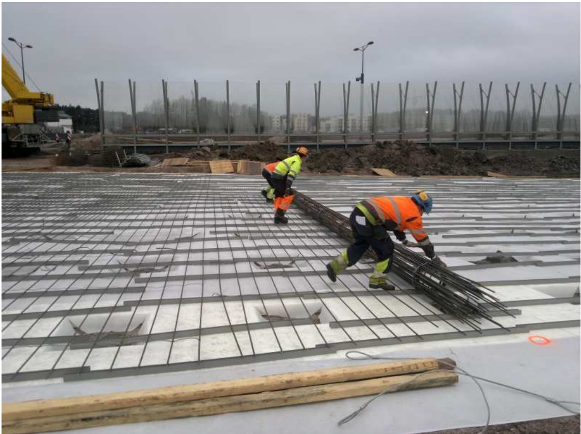
Kuva 5. Bamtec-mattoraudoitteen levittämistä [13]
