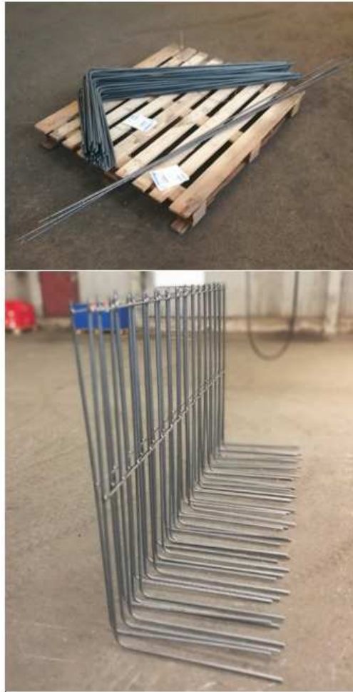
Kuva 9. Yllä: Irtorautoitteita, alla: Valmis komponentti
