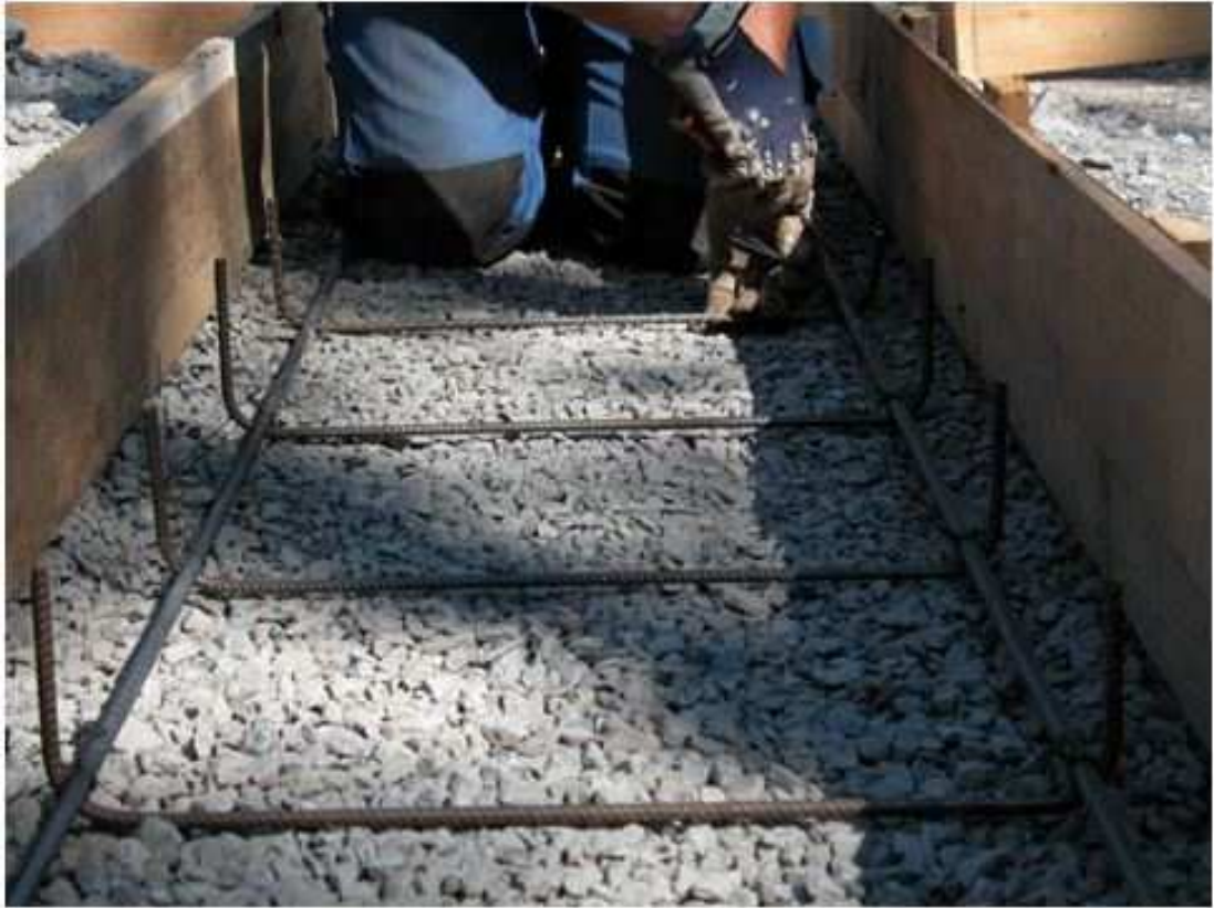
Kuva 8. Raudoittamista suoraan muottiin [12]
