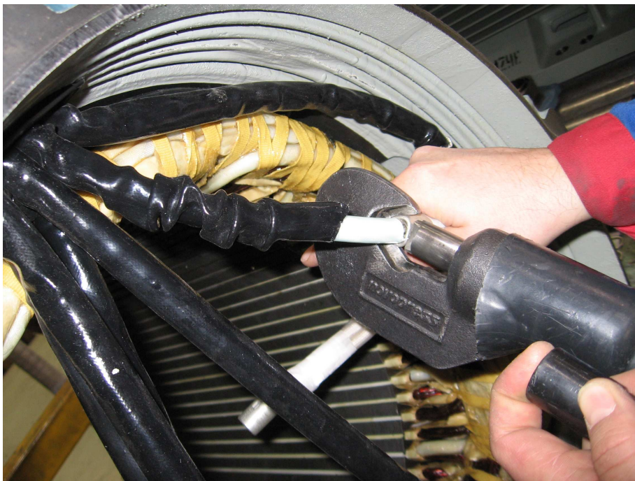
Kuva 5. Vaihejohtimien liittäminen.
