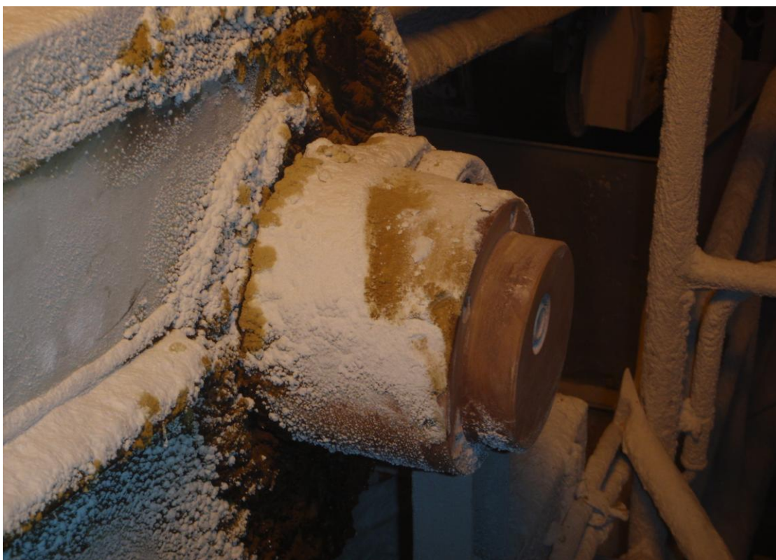
Kuva 11. Nousevan hihnakuljettimen L1109 takaisinpyörintäjarru
