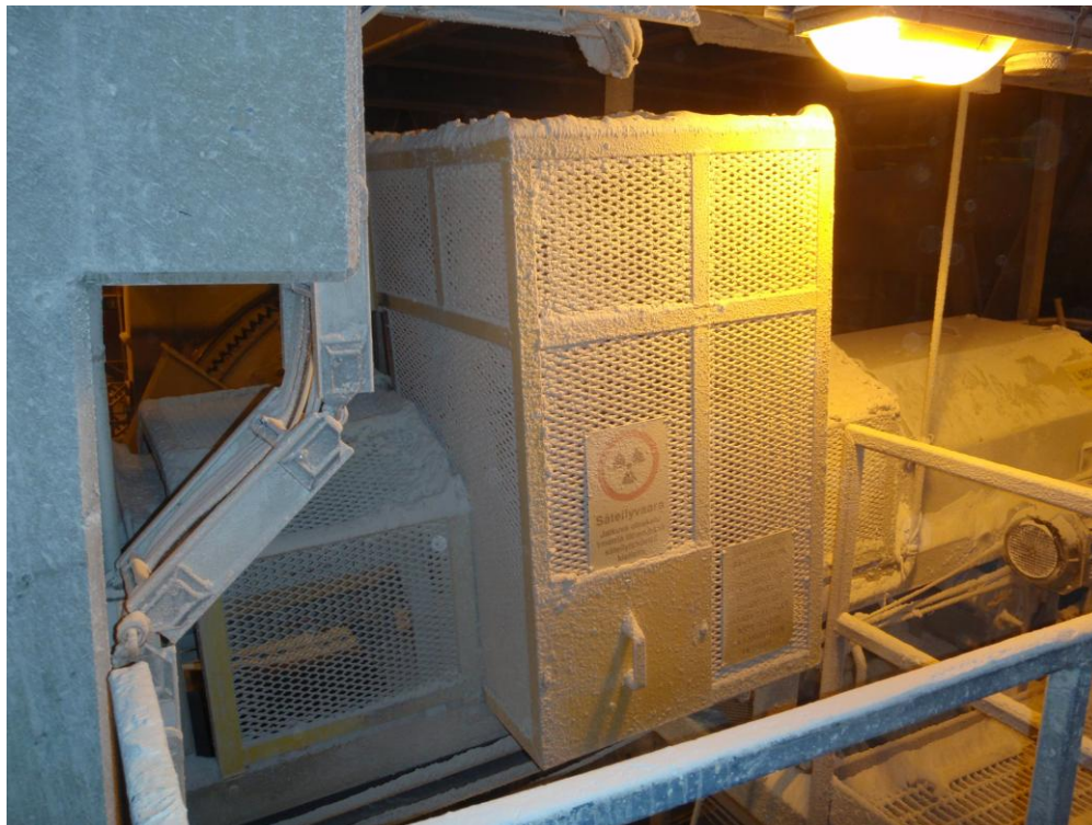
Kuva 9. Hyvin suojattu hihnakuljettimen rumpu
