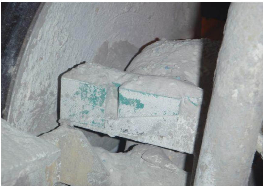
Kuva 6. Yaran hihnakuljettimen pyörintävahti.
