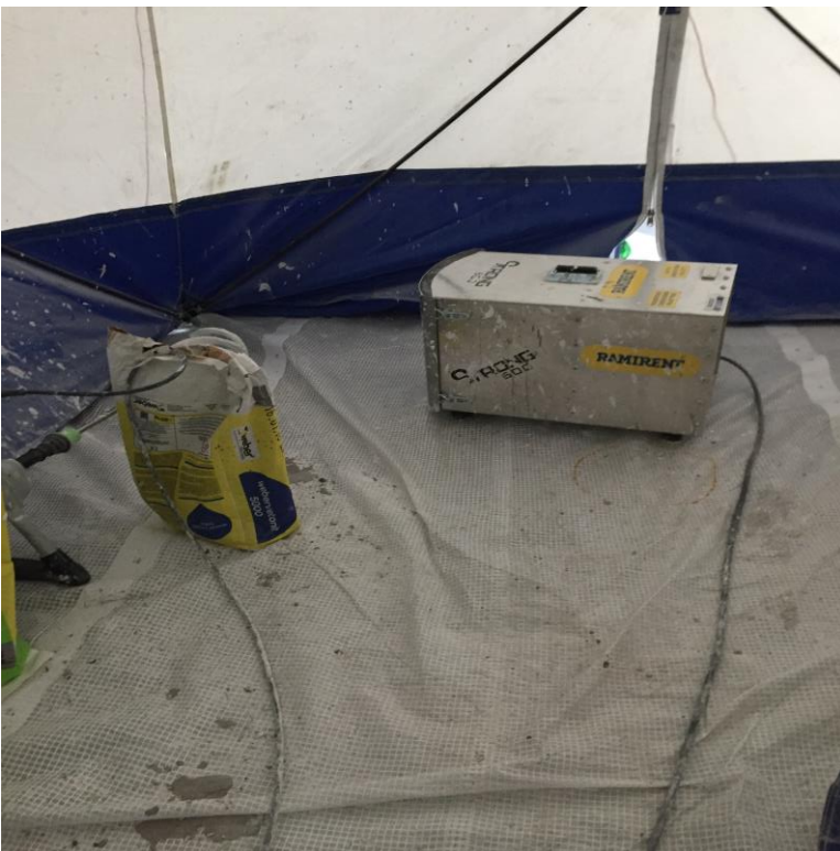
KUVA 8. Kohdepoistolaite laastinsekoitusteltan sisäpuolella. Säkit avattiin kohdepoistolaitteen edessä
