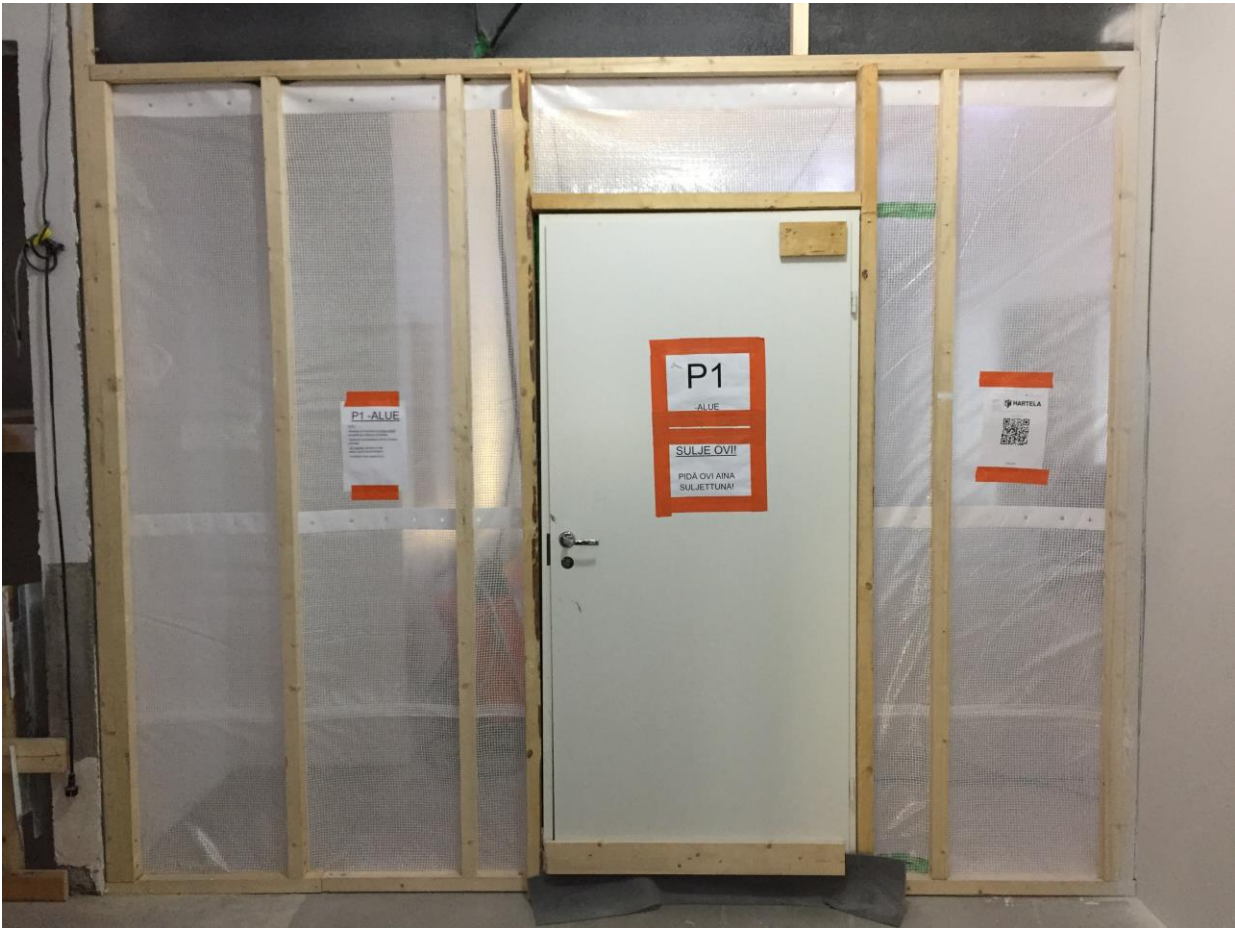
KUVA 5. P1-osaston väliseinä Linnukan koulun puhtaan ja likaisen osaston välissä
