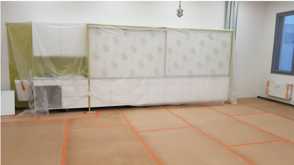
KUVA 12. Pölynsuojaamiseksi huputettu kiintokaluste
