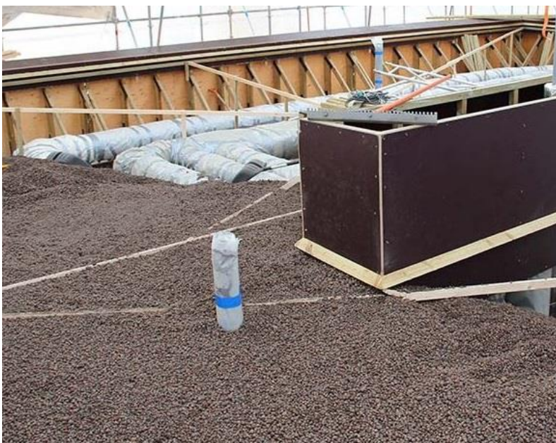
KUVA 4 Leca-soran asennustyöt ilmanvaihtokanavien ympärille vesikatolla (10, s. 1)
