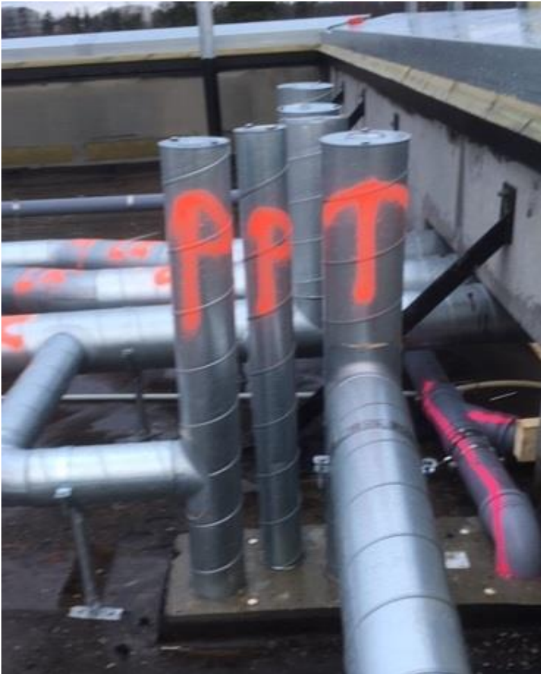
KUVA 5 Ilmanvaihtokanava-asennukset asuinkeuhkoston vesikatolla
