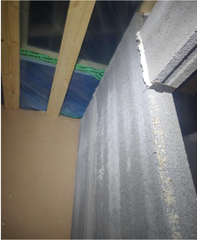
Kuva 14. Ovenylityspalkki asennettuna. As Oy Nurmijärven Hallakko, 18.10.2018.
