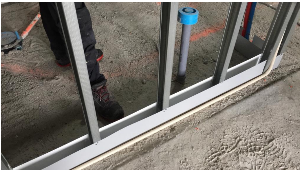
Kuva 7. Väliseinärungon korkeampi pohjakisko. As Oy Tampereen Konkari, 20.5.2018.
