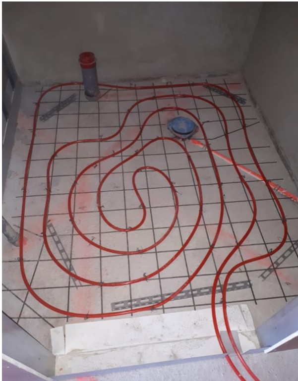
Kuva 22. Kylpyhuoneen raakavalun päälle asennettu teräsverkko sekä lattia- lämmitysputkisto. As Oy Tampereen Konkari, 27.6.2018.
