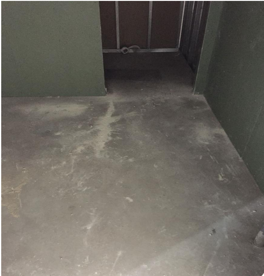
Kuva 10. Märkätilan seinät levytetty sisäpuolelta ja kaatolattia valettu. As Oy Tampereen Konkari, 29.6.2018.
