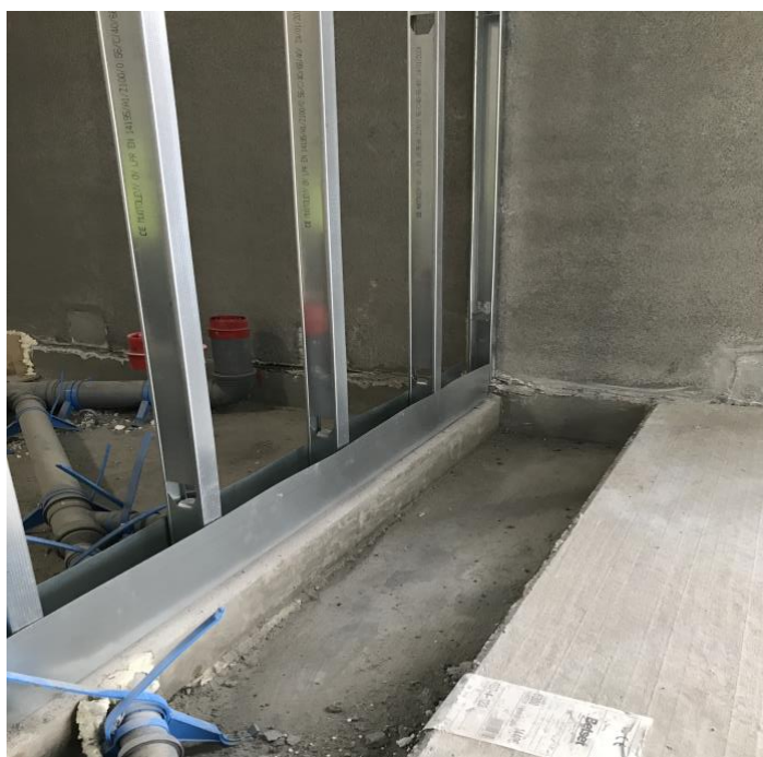
Kuva 12. Väliseinärungon pohjakisko asennettu valetun anturan päälle sekä pystyrangat asennettu. As Oy Tampereen Gabro, 28.2.2019.
