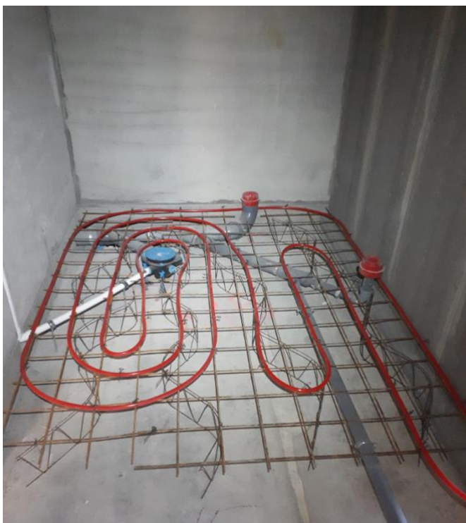
Kuva 19. Lattialämmitysputket kiinnitettynä teräsverkkoon. As Oy Nurmijärven Hurmuri, 21.11.2018.
