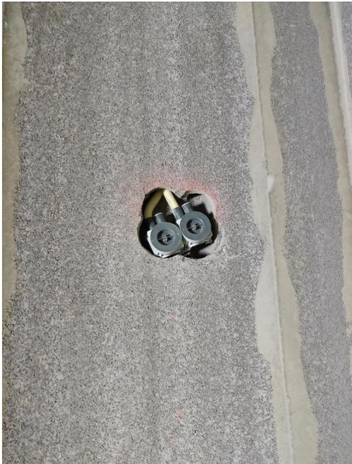
Kuva 16. Sähkörasiat asennettuna AKO-elementtiin. As Oy Nurmijärven Hallakko, 18.10.2018.
