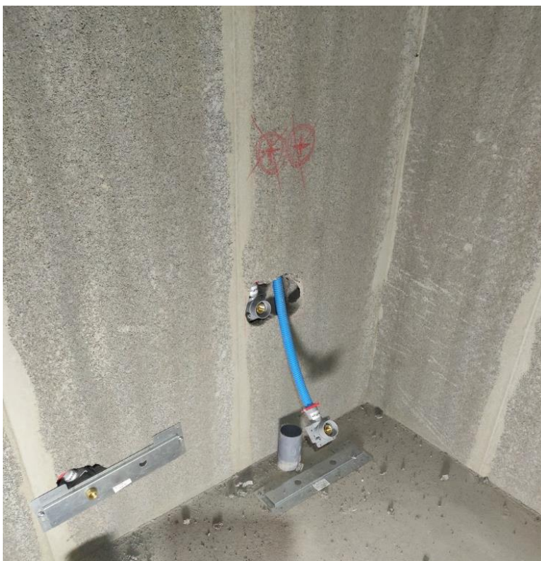
Kuva 17. Hanakulmien asennusta AKO-elementtiin. As Oy Nurmijärven Hallakko, 18.10.2018.
