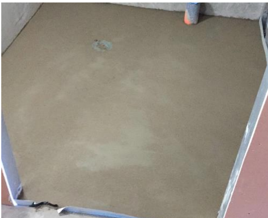
Kuva 20. Hierretty kylpyhuoneen kaatolattia. As Oy Tampereen Konkari, 21.6.2018.
