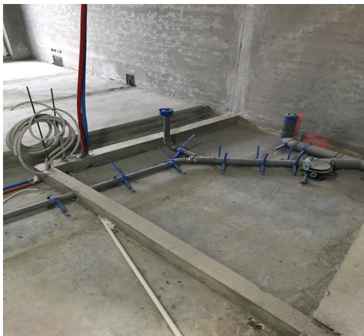
Kuva 11. Muottivanerit poistettu valetun anturan ympäriltä. As Oy Tampereen Gabro, 28.2.2019.
