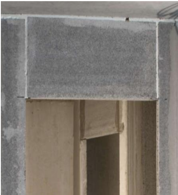
Kuva 15. Ovenylityspalkki asennettu AKO-seinään /9/.
