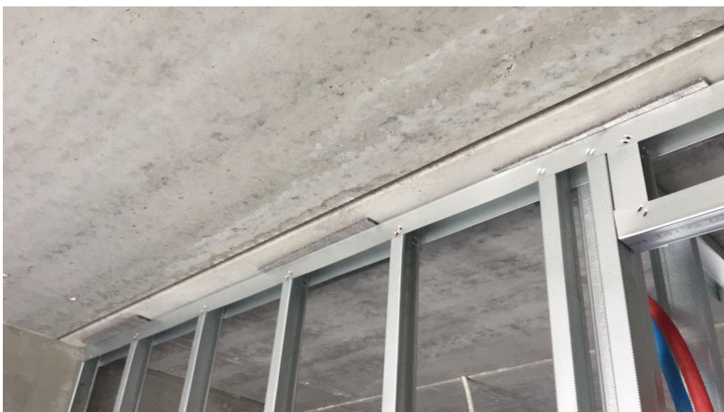
Kuva 8. Ontelolaattaan kiinnitetty väliseinärungon vaakakisko. As Oy Tampereen Konkari, 18.5.2018.
