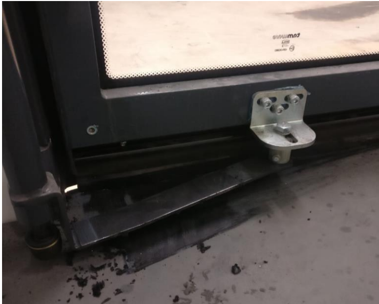
KUVA 3. Alatiivistyksen komponentit kuvattuna sisältä päin (Poutanen 2019)
