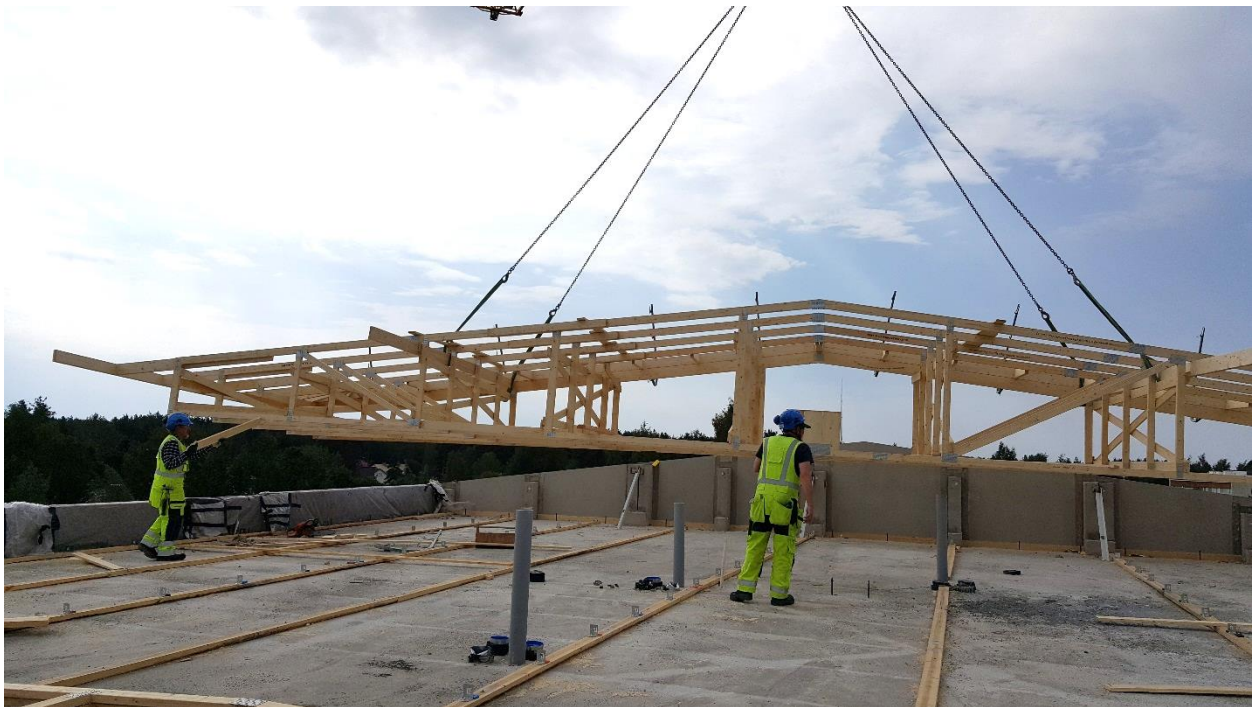
KUVA 6. Rästiselementin paikoilleen nostoa
