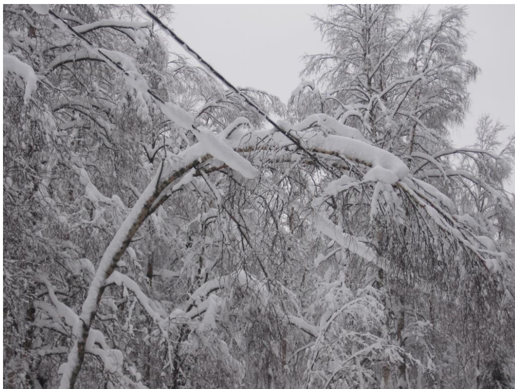
Kuva 12. Kaatunut puu PAS-linjaa vasten.
