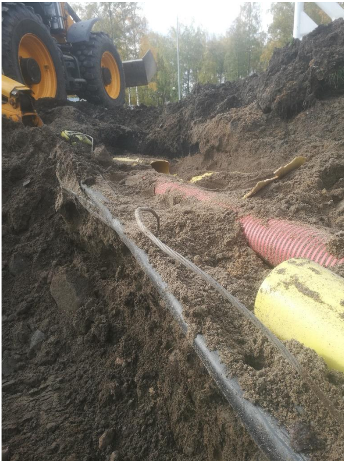
Kuva 6. Maakaapelointi putkitusten yhteydessä. Kaapelit noin metrin syvyydessä.
