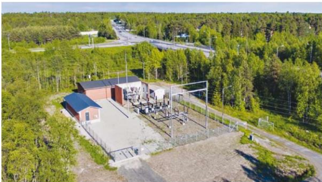
Kuva 1. Karihaaran sähköasema. (Kemin Energian ja Veden vuosikertomus 2017.)
