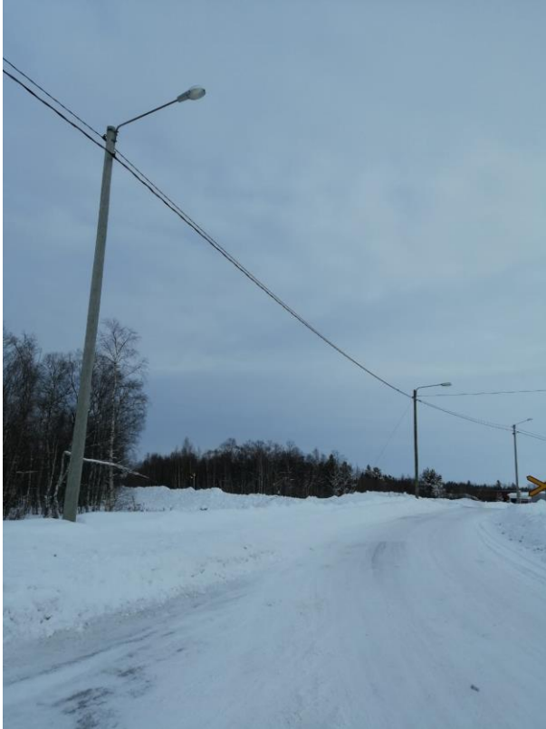
Kuva 5. Ilmajohdo asennustapa. Kuvassa ilmalinja Kemin ajoksessa.
