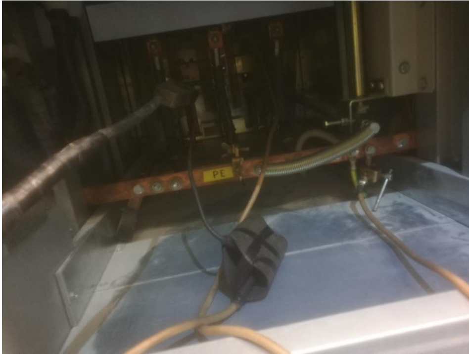
Kuva 15. Syöksyaaltogeneraattorin johdot kytketty vialliseen vaiheeseen ja suo- jamaan kiskoon.
