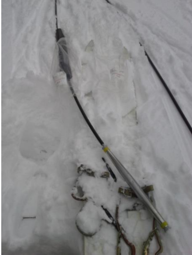
Kuva 14. PAS-johdon kuorinta ja jatkosholkin laittaminen kuoritun johtimen päähän sekä kutistemuovin pujottaminen jatkosholkin yli.
