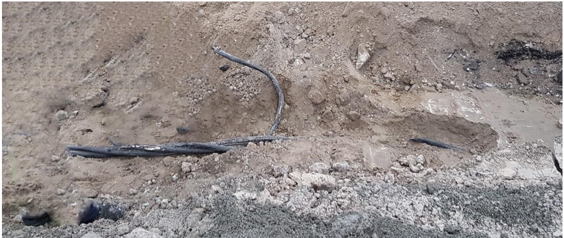
Kuva 17. AHXAMK-W kaapeli Outokummussa, josta yksivaihe kokonaan poikki.
