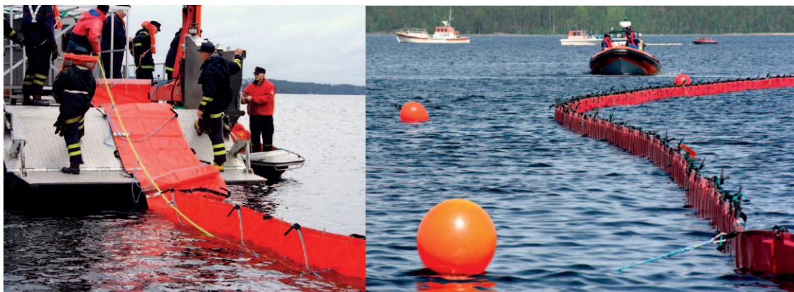
Kuva 38. Puomin laskua aluksen kannelta ja ankkuroitua puomia (Pohjois-Savon pelastuslaitos).
