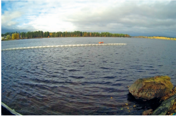
Kuva 29. Paravaani-puomitus, sama tilanne rannalta ja ilmasta katsottuna. Puomituksen muoto on huomattavasti helpompi hahmottaa ilmakuvasta. RPAS-kuvan perusteella havaittiin puomin jääneen liikaa pussittamaan. Tilanne korjattiin siirtämällä puomin rantakiinnityspistettä kauemmas alavirtaan. (Rantavuo 2017 ja Pitkäaho 2017)
