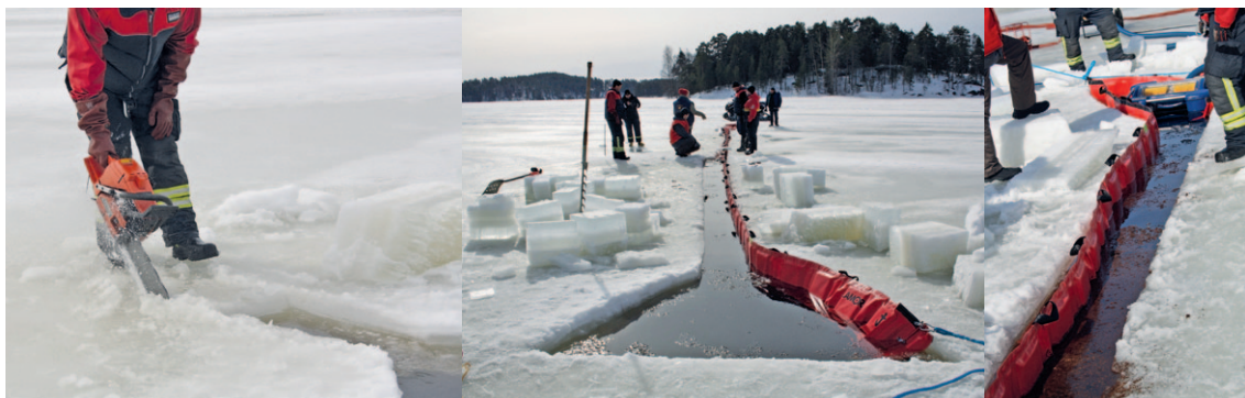
Kuva 31. Puomitusrailon ja keruualueen sahaaminen. Kuvat Pohjois-Savon jääolosuhteiden torjuntaharjoituksesta. (Halonen 2018).
