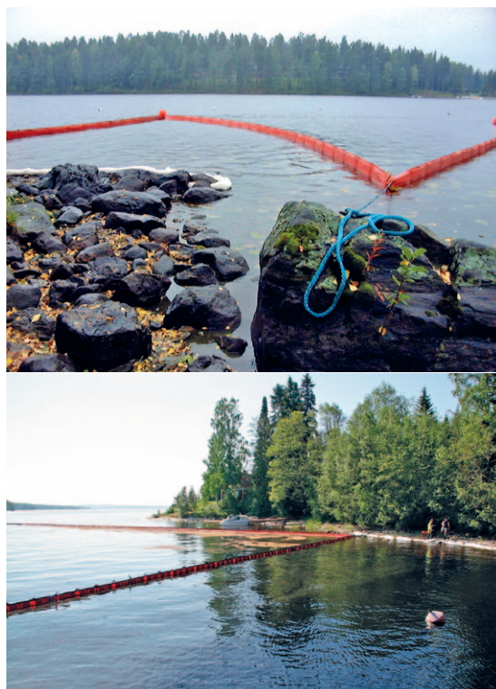
Kuva 32. Rannan suojapuomituksen tulee muodostaa alueita, joihin öljy alkaa kertyä, muutoin ongelma vain siirtyy eteenpäin. Tällaisia ovat esimerkiksi siksak-puomituksen taskut. (Pohjois-Savon pelastuslaitos)
