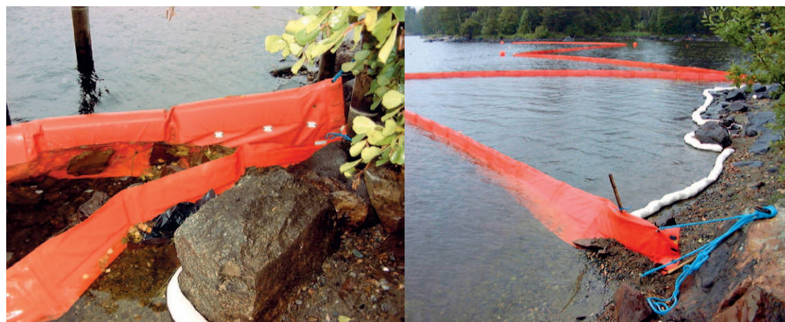
Kuva 33. Rantapuomituksen kiinnitys. Puomin taitetun reunan päälle on laitettu painoksi kiviä, jotta kiinnityksestä tulee tiivis. (Pohjois-Savon pelastuslaitos)
