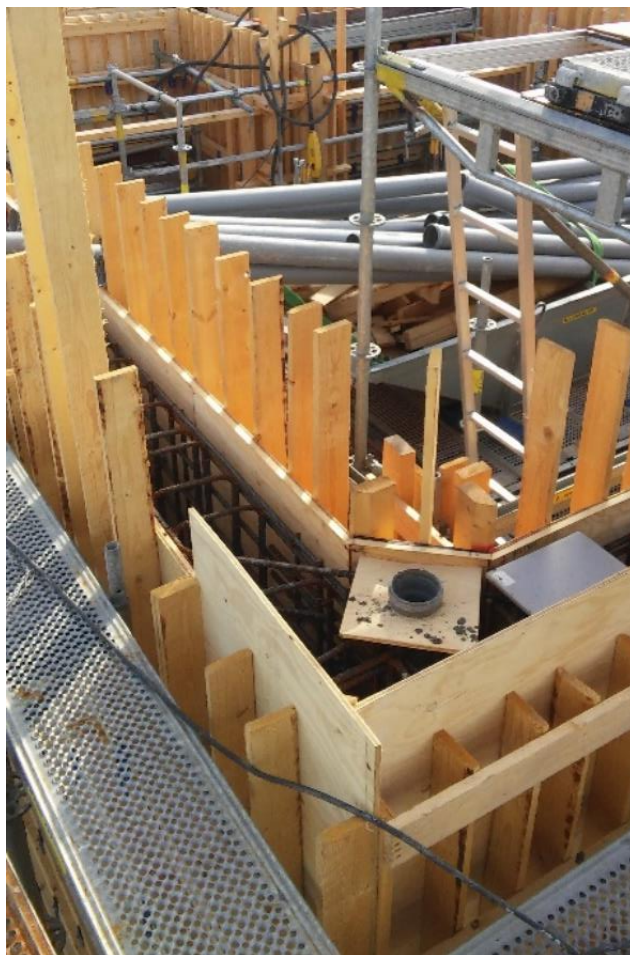
Kuva 5. Valuputkia, jotka vaihdetaan toisiin valun pinnan noustessa
