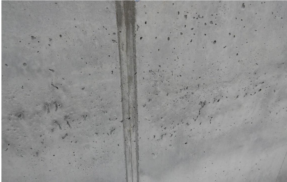
Kuva 8. Betoni jää huokoiseksi, jos jälkitiivistys on huolimaton
