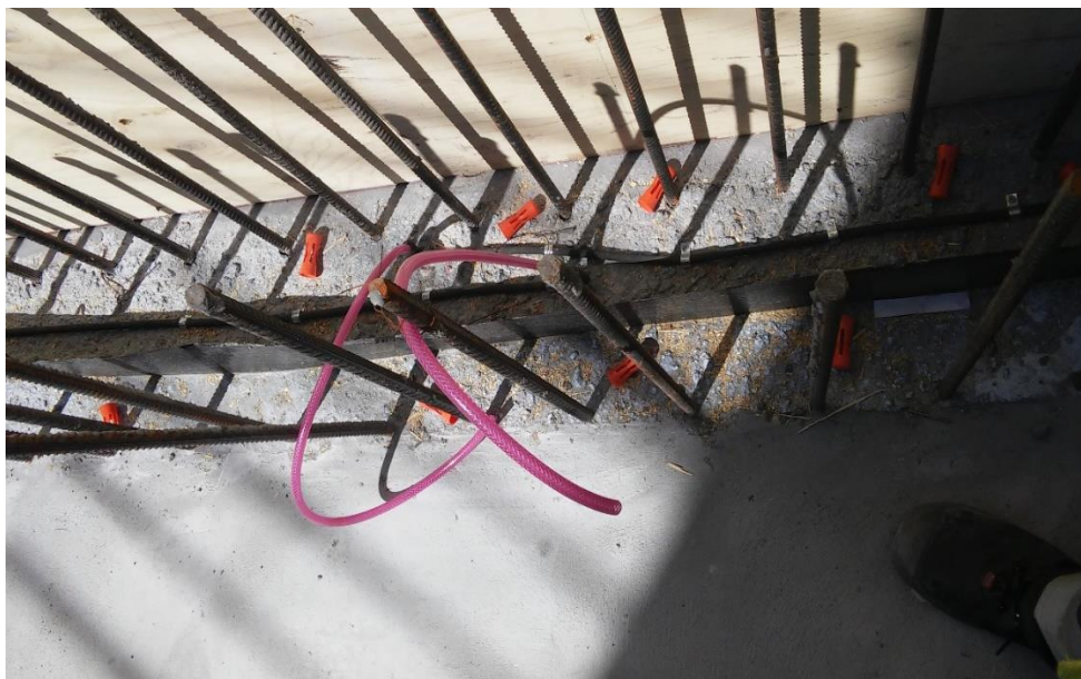
Kuva 9. Laatan ja seinän välinen saumakohta saadaan vesitiiviiksi injektioimalla
