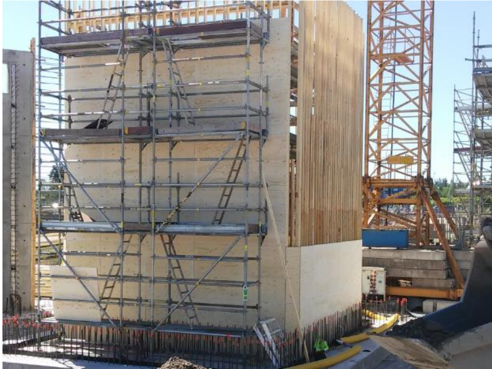
Kuva 1. Kappaletavaramuotin ykköspanuoli, joka tehdään ennen raudoitusta
