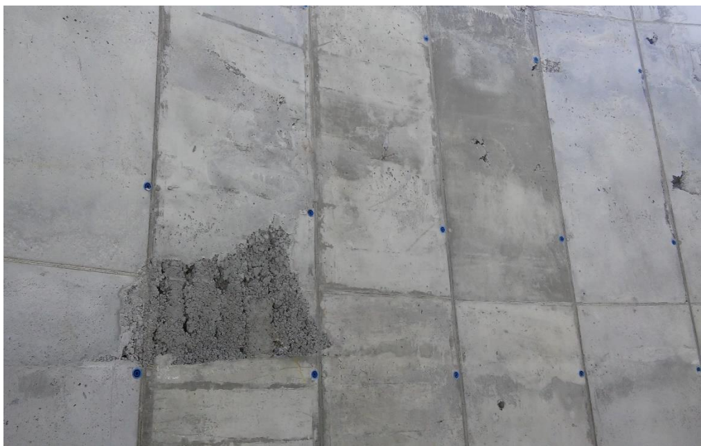
Kuva 7. Heikko tiivistys jättää betoniin rotankoloja ja pinta on harvaa
