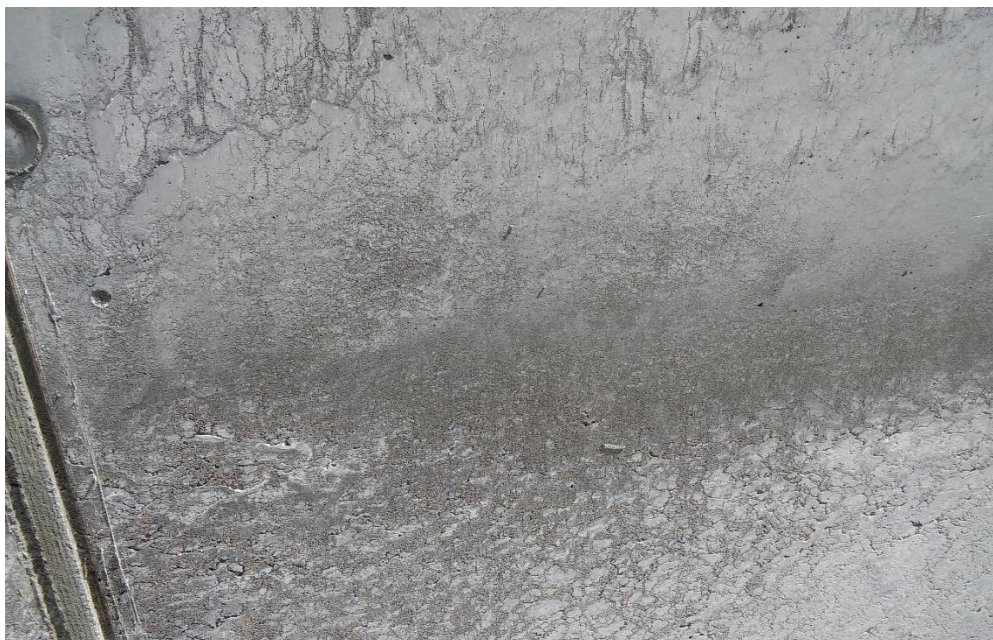
Kuva 6. Liiallisen tärytyksen seurauksena betoni erottuu
