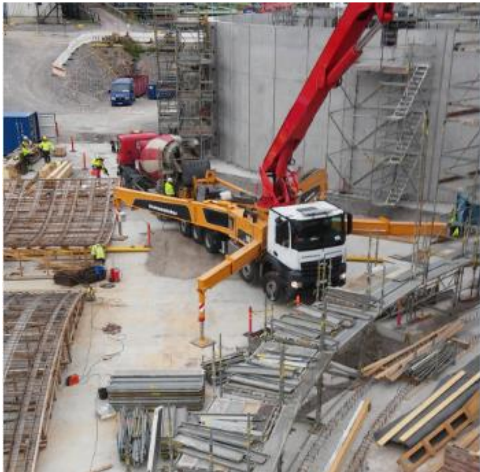
Kuva 4. 56-metrinen betonipumppu paalulaatan päällä
