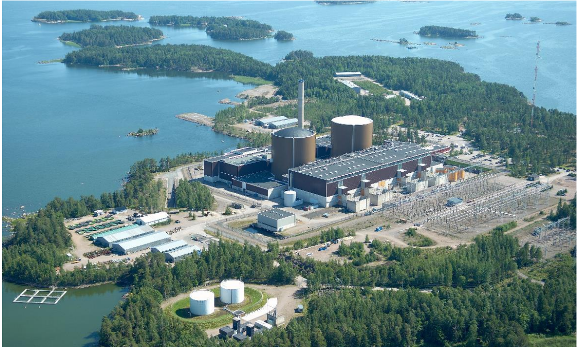
Kuva 2 Loviisan voimalaitos [Fortum mediapankki 2018]
