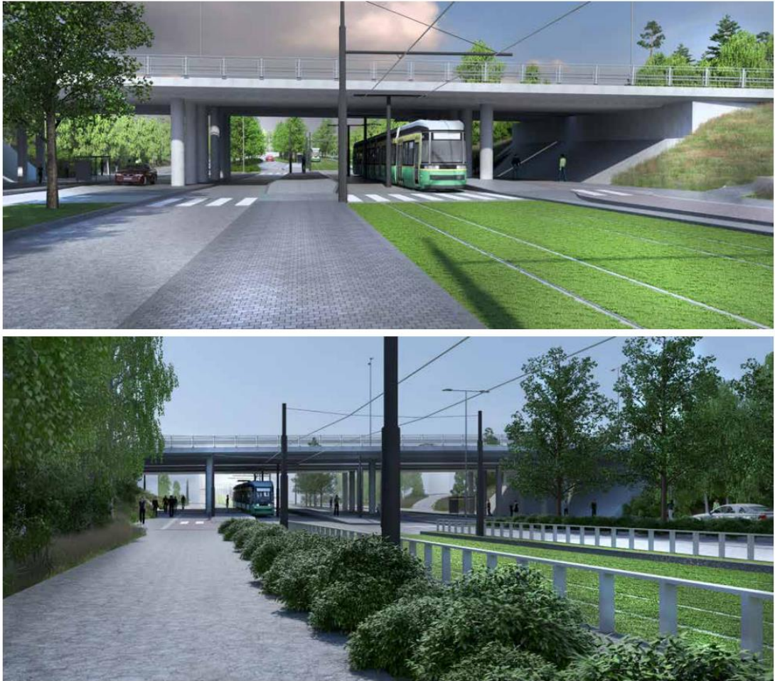
Kuva 10. Havainnekuva, ylemmässä kuvassa kiristetty ajojohdinjärjestelmä ilman kannatinta, alemmassa kuvassa ajojohdinjärjestelmä on toteutettu köysiportaaliripustuksilla. Kuvat eivät ole teknisesti tarkkoja. [4, s.19.]
