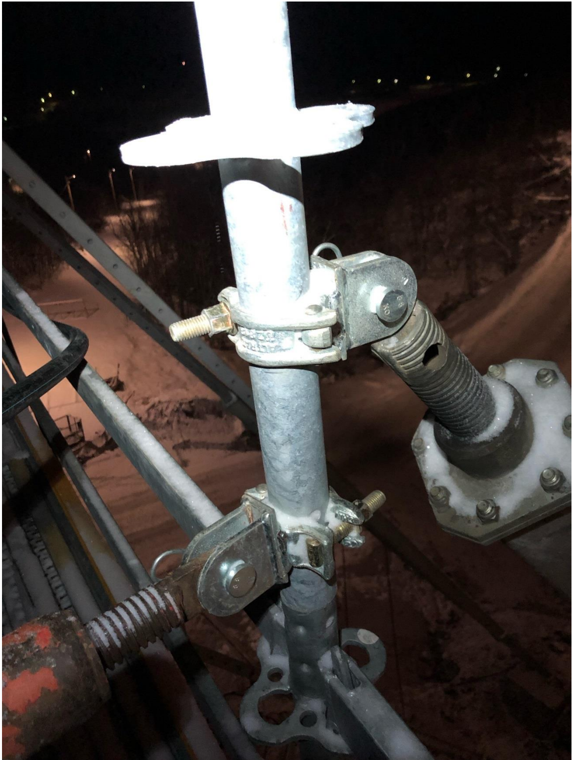
Vaakatönärin kiinnitys telineeseen.
