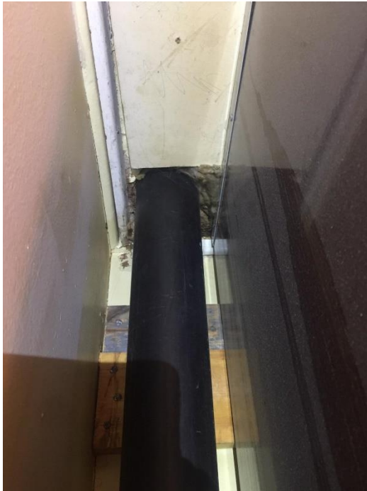
Kuvio 8. Viemärintuuletusputken läpivienti (Ravelin 2019).
