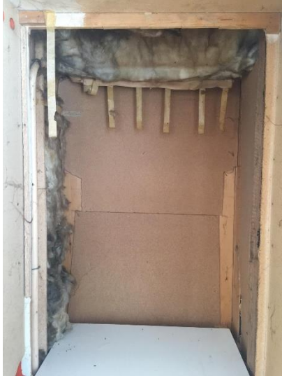
Kuvio 9. Jääkaapin takana oleva mineraalivilla (Ravelin 2019)
