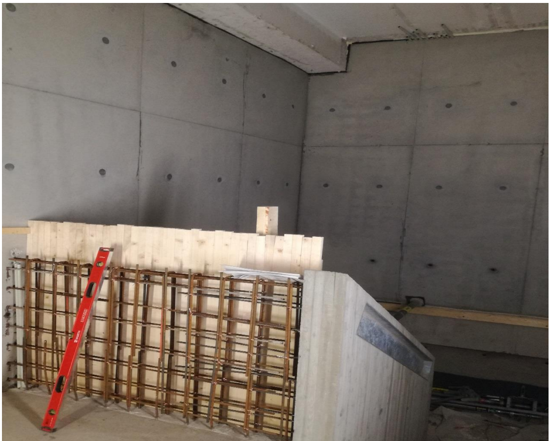
KUVA 2. Olympiastadionin työmaalla itsestivistävällä betonilla toteutettuja A-luokan väribetonirakenteita.
