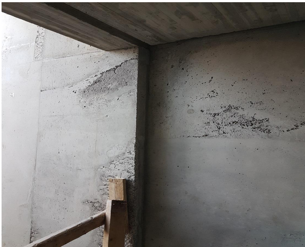
KUVA 3. Olympiastadionin työmaalla tapahtunut harvavalu.
