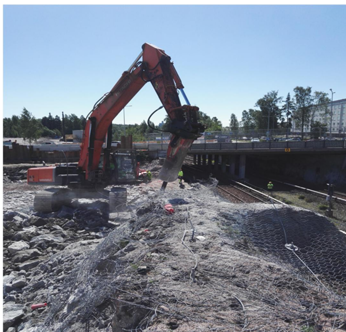
Kuva 5. Etanoinnin jälkeistä kiven irrotusta ja rikotusta työmaalla.
