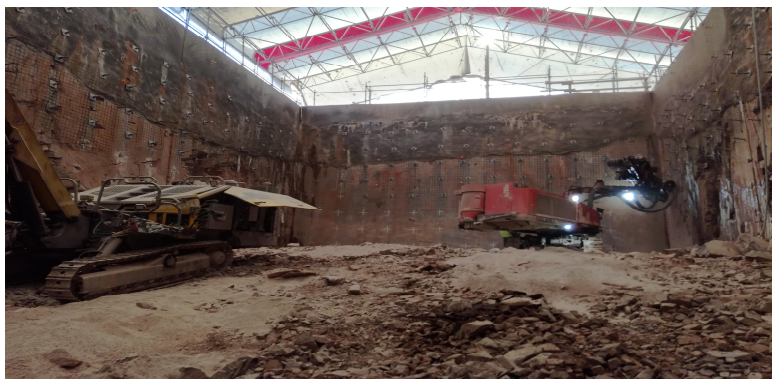
Kuva 8. Vaakapulttireikienporausta louhitussa metroasemakuilussa.
