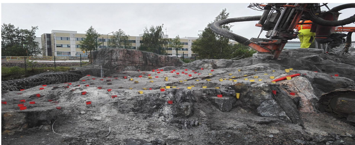
Kuva 2. Tiheästi porattu kalliokenttä räjähdysaineettomalle louhinnalle (paisuntalaasti).
