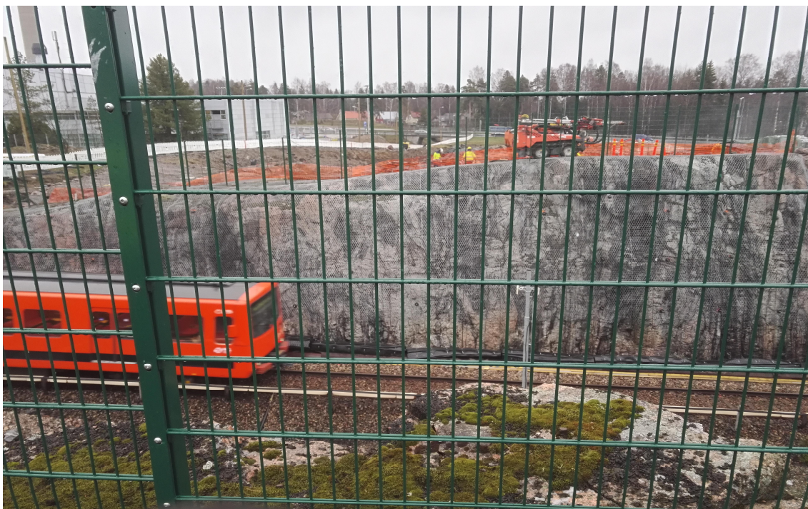
Kuva 10. Louhittava verkotettu kallioalue metroradan vieressä.
