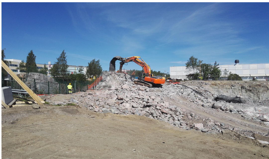
Kuva 11. Metroradan viereisen kallion rikutusta paisuntalaastin vaikutuksen (1vrk) jälkeen.
