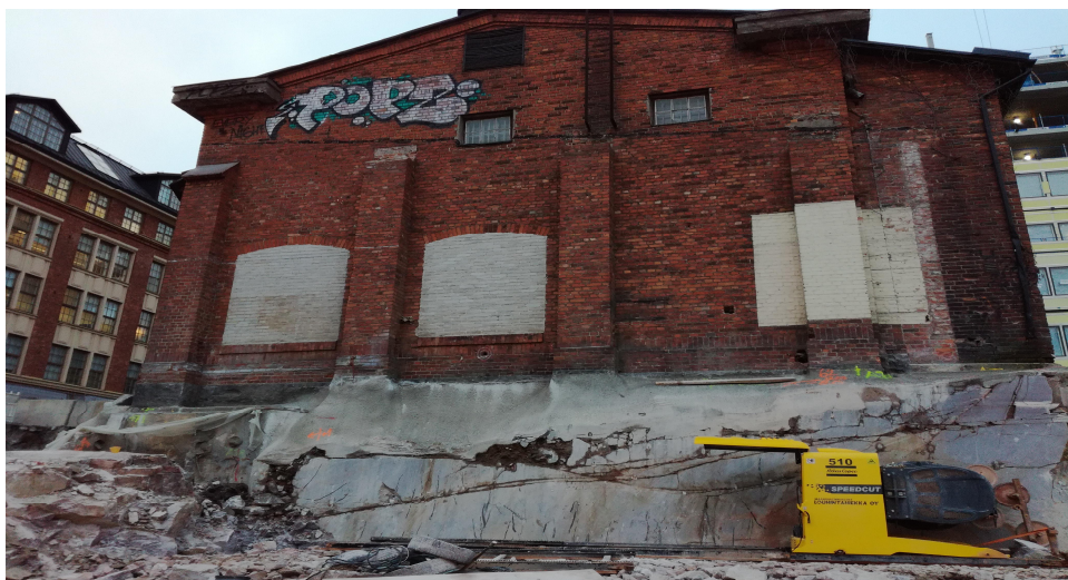
Kuva 7. Speedcut vaijerisahausyksikkö työmaalla sahaamassa railoa kalliioon.
