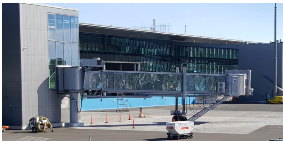
Kuva 2. Lentoaseman laajennuksen yhteydessä asennettu ajettava matkustajasilta
