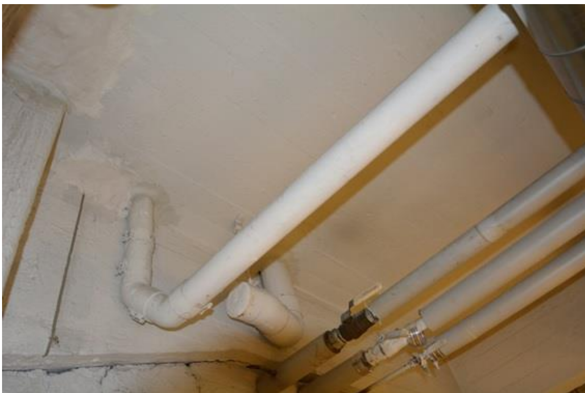
Kuva 9. Aukkojen tiivistäminen. Osastoivaan osaan putken ympärille massaa (tässä tapauksessa Joints-kipsimassa) sekä katkaistun putken päähän massalla täyttö.
