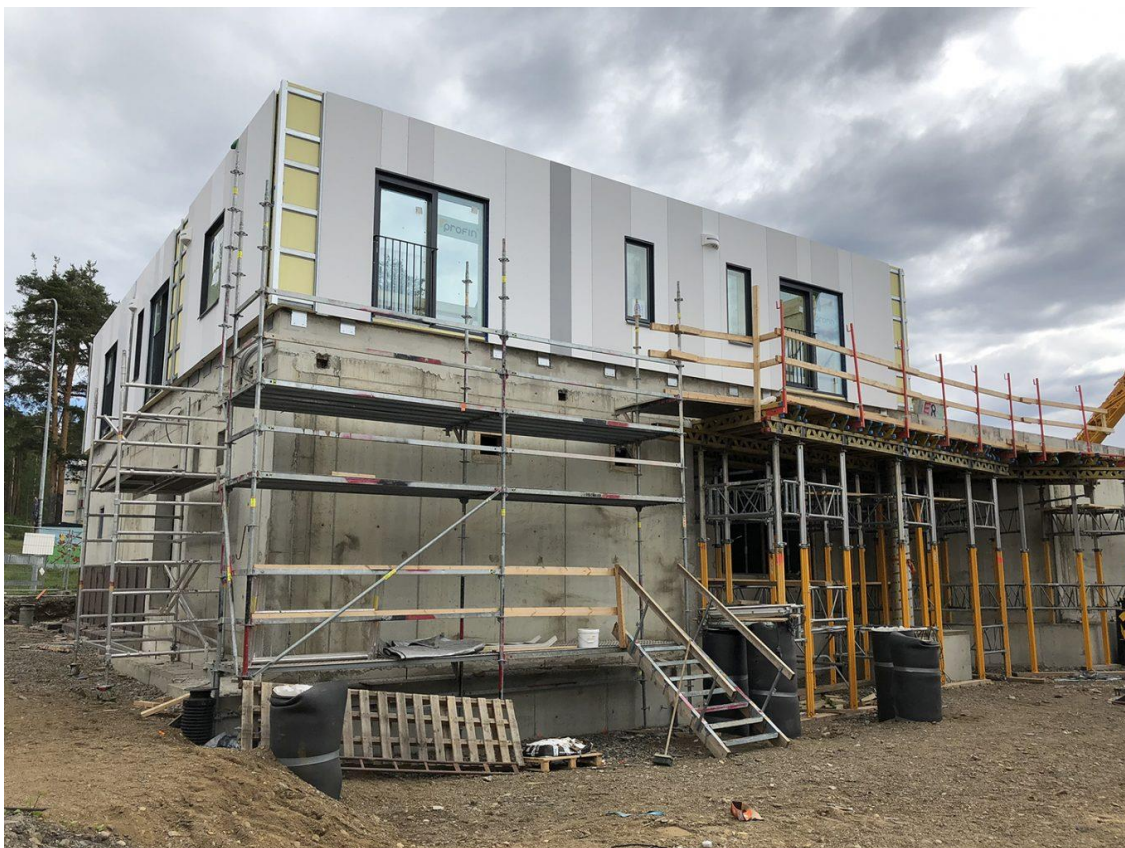
Kuva 4. Joensuu Lighthousen betoninen pohjakerros ja ensimmäinen puurakenteinen asuinkerros [12].
