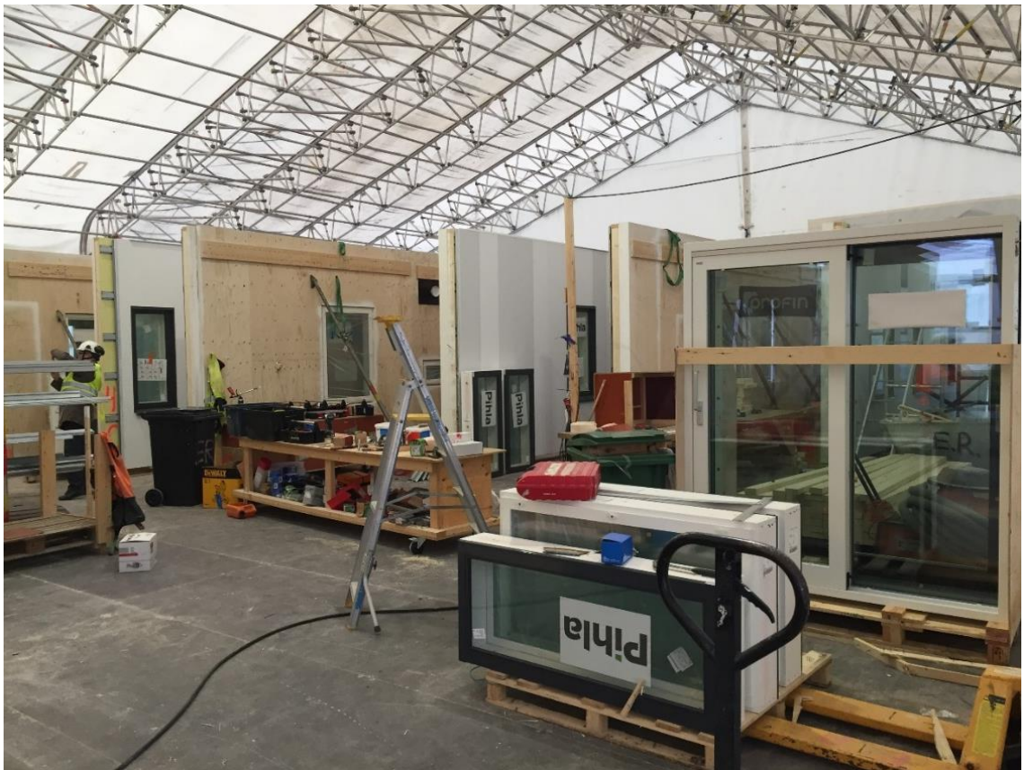
Kuva 10. Joensuu Lighthousen työmaa-aikainen suojateltta.
