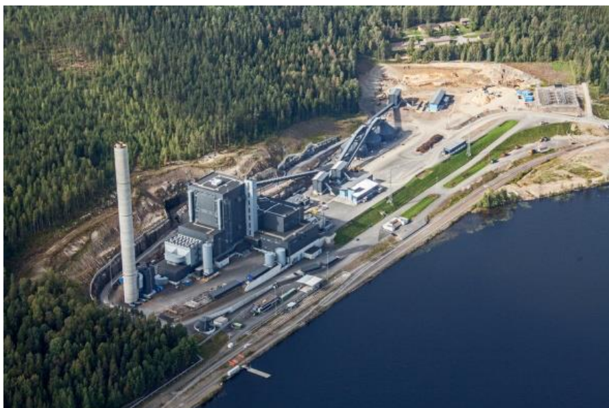
KUVA 1. Keljonlahden voimalaitos (Jyväskylän Energia 2019).
