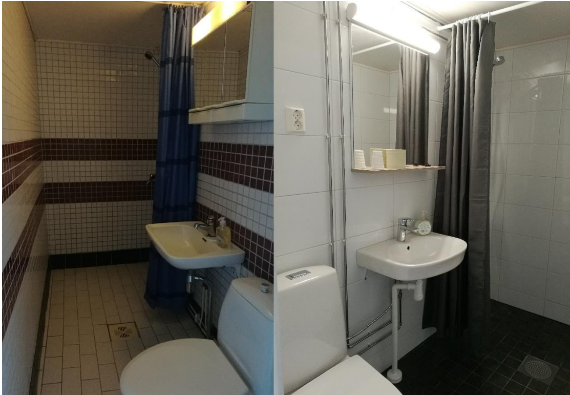
Kuva 4. Yläkerran huoneiden kylpyhuoneet Hotel Juliella (Kuva: Heini Ryyänen).
