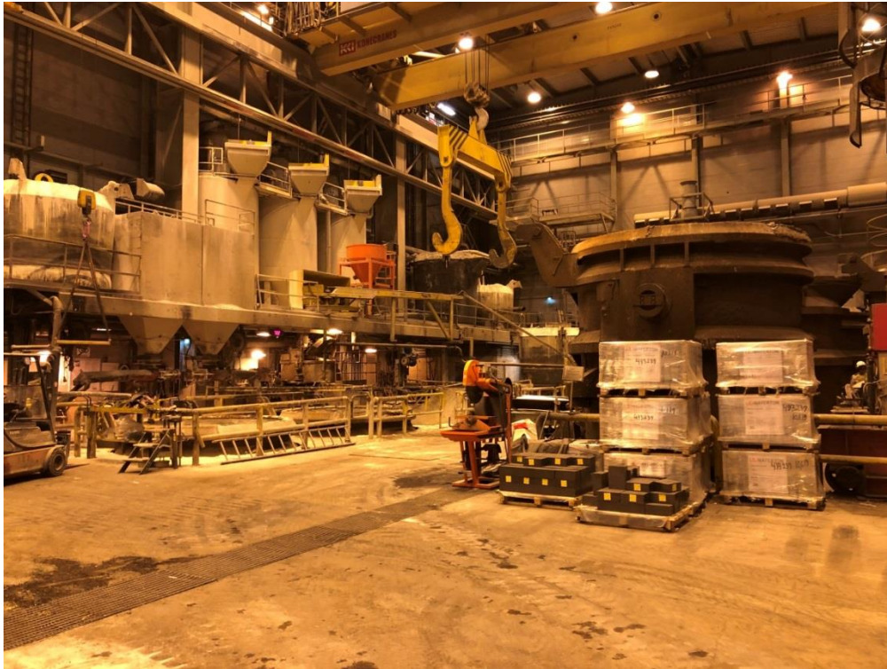
KUVA 11. Muurausmonttu ja massasiilot
