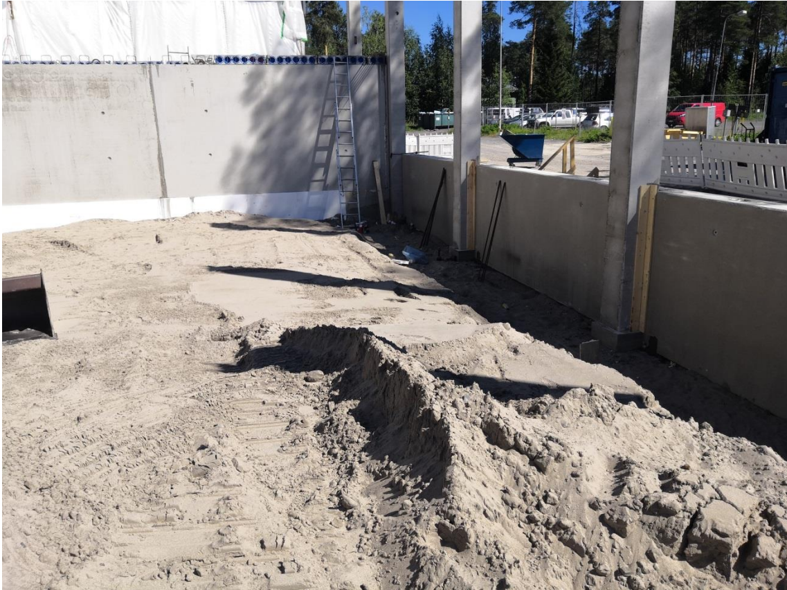
KUVA 6. Hiekkatäyttö
