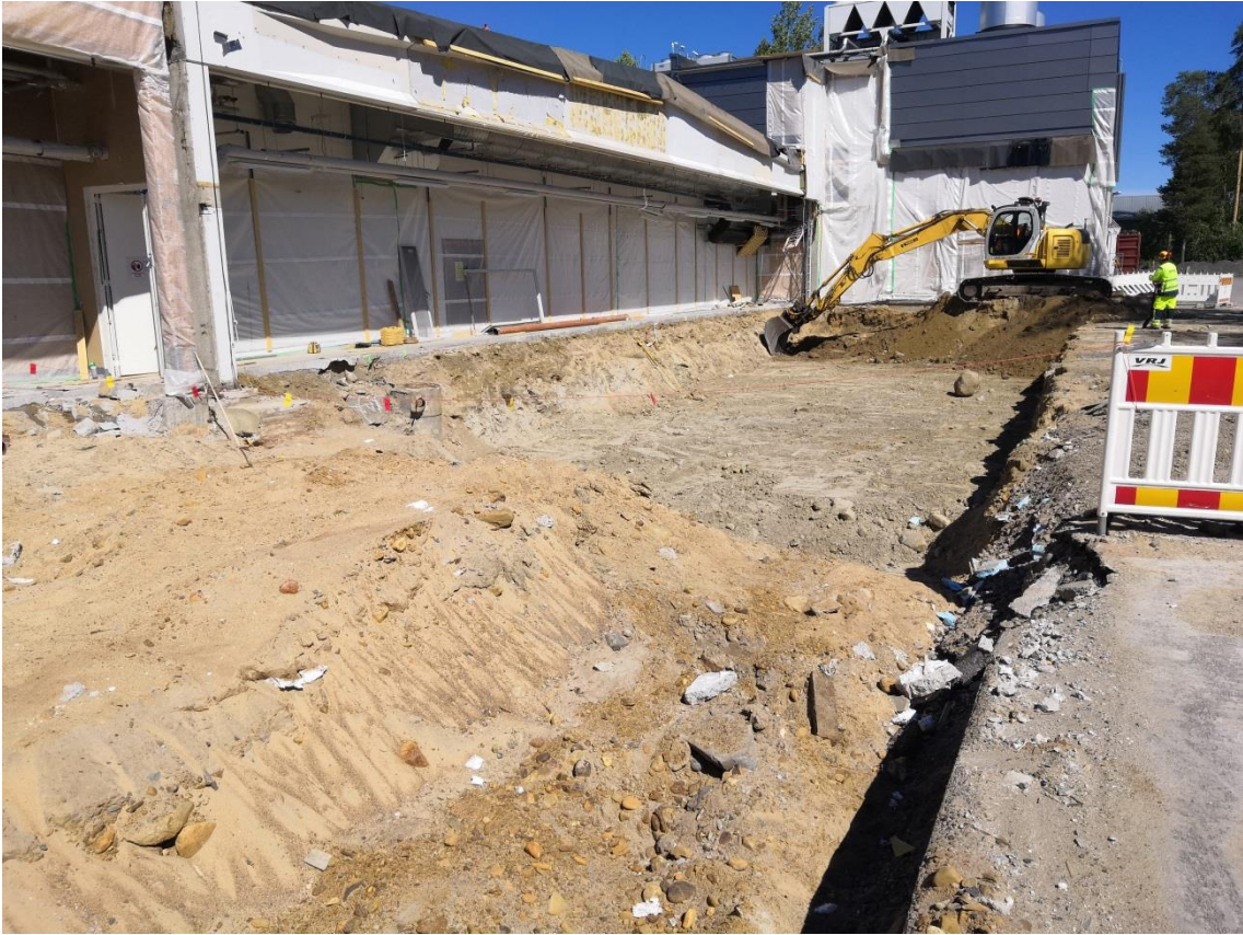
KUVA 4. Hallin laajennuksen maaleikkaus käynnissä
