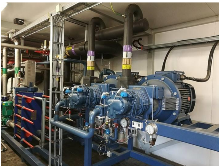
Kuva 39. Kylmän tuotto tapahtuu kahden rinnakkain kytketyn ruuvikompressorin avulla.
