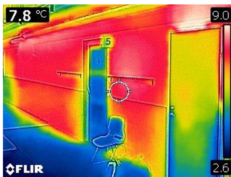
Kuva 54. Puolilämpöiseen tilaan rajoittuvat pukuhuoneiden seinustat näkyvät muihin rakenteisiin verrattuna selkeästi lämpöisempinä.
