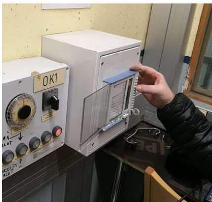
Kuva 47. Puhaltimien ohjaus tapahtui käsikäyttöisesti Siemensin ohjausjärjestelmällä, mikä on ollut käytössä jäähallin alusta asti.
