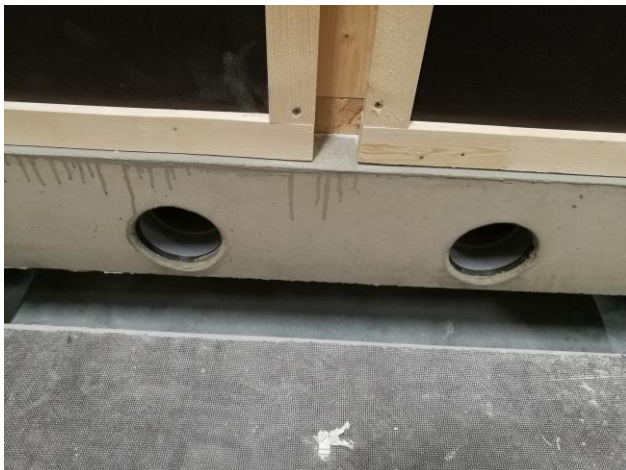
Kuva 12. Nykyään viemärit kulkevat kylpyhuonemuodulin betonilaatassa, joka helpottaa asennusta. Lähde Marko Lehtonen
