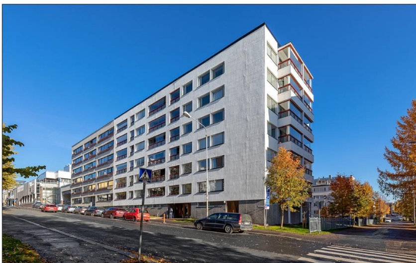
Kuva 1. As Kuopion Savonkatu 9. Kohteessa tehtiin perinteinen LVIS-saneeraus, julkisivu- ja parvekkeiden kunnostus. (KUMONI Oy 2018)
