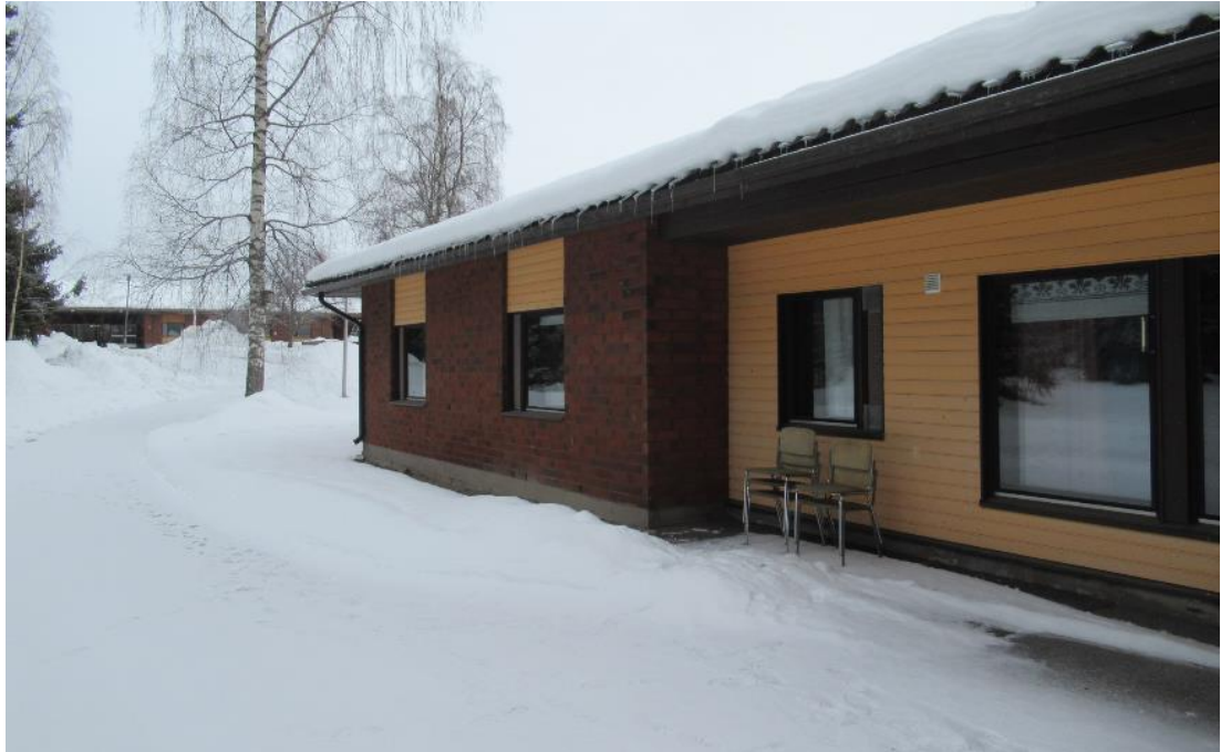
Kuva 3. Yleiskuva rakennuksen länsisivusta. Kuvan vasemmassa reunassa asfaltoitu pihaväylä, joka jatkuu sisääntulosyvennyksessä sokkeliin kiinni. Maanpinta viettää rakennuksen pohjoispäätä kohti.
