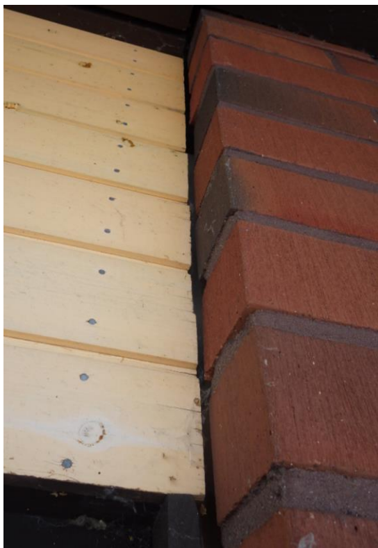
Kuva 28 a ja b. Tiiliverhouksen ja ikkuna-/paneelirakenteen välisissä liitoksissa havaittiin selviä rakoja, joista suora yhteys eristetilaan. Paneeliverhoillut osat ovat tuulettumattomia, koska alapinnan tuuletusväli on tukittu ikkunan pielilaudalla (kuva b, nuoli).
