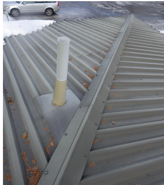
Kuva 47 a ja b. Katolla oli asianmukaiset tikkaat ja huoltotaso. Vesikatteessa oli huippu- puimurin, antennin ja viemärin tuuletusputken läpiviennit. Katteen kiinnitystä on jäl- keenpäin parannettu kateruuveilla.
