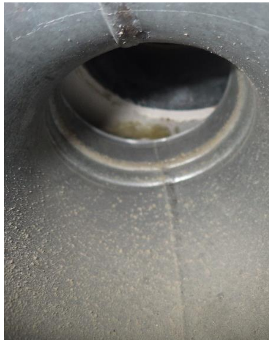
Kuva 67 a ja b. Kanavistossa havaittiin runsaasti epäpuhtauksia. Wc-tilan 028 päätelaitteen irrotuksen yhteydessä havaittiin kanavien irtonainen liitos.
