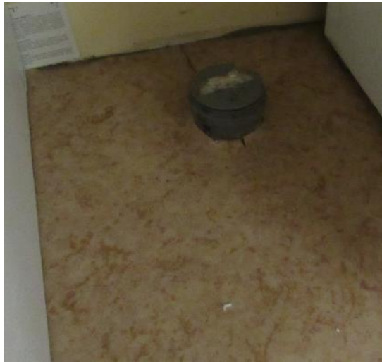
Kuva 12 a ja b. Taukutilassa ja huoneessa H030 sijaitsevista viemärin läpivienneissä lattiapäällystystä ei ole kiinnitetty putkeen tiiviisti tai päällyste puuttuu.
