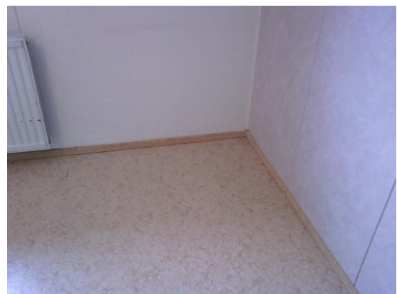
Kuva 13 a ja b. Lämpökamerakuva ulkoseinän, väliseinän ja alapohjan liittymäkohdasta, jossa havaittiin merkittäviä ilma-/lämpövuotoja. Väliseinän kohdalla on ulkoseinäelementtien saumakohta.
