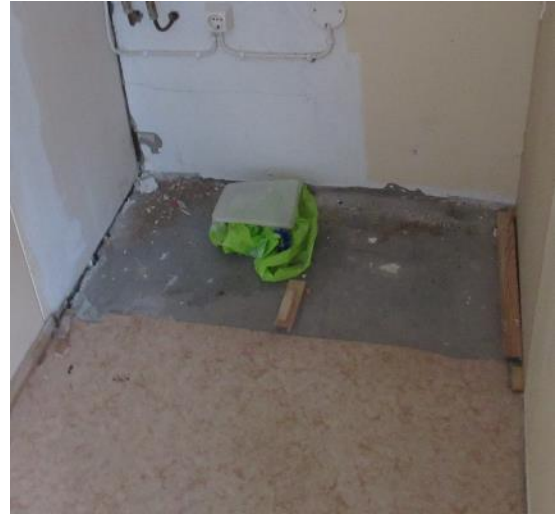
Kuva 12 a ja b. Taukutilassa ja huoneessa H030 sijaitsevista viemärin läpivienneissä lattiapäällystystä ei ole kiinnitetty putkeen tiiviisti tai päällyste puuttuu.
