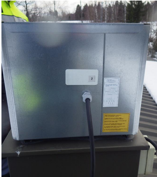
Kuva 64 a ja b. Kuva huippuimurista. Malli: HiFEK-03-4/8-1-1-1, moottori: 0,12/0,02 kW 1400/705 RPM.
