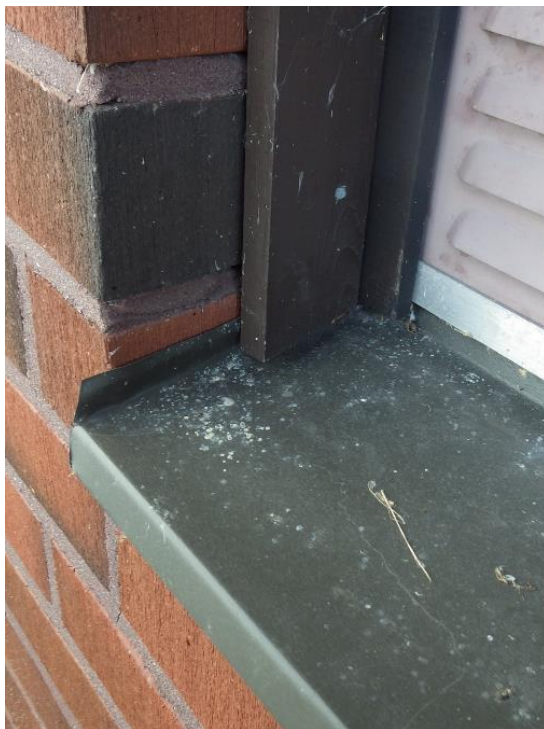
Kuva 30 a ja b. Tiiliverhoiluissa kohdissa ikkunapellityksien kallistukset ovat osittain riittämättömiä eikä ikkunapeltien liittymiä ole tiivistetty. Lisäksi ikkunapeltien naulakiinnitys on puutteellinen.
