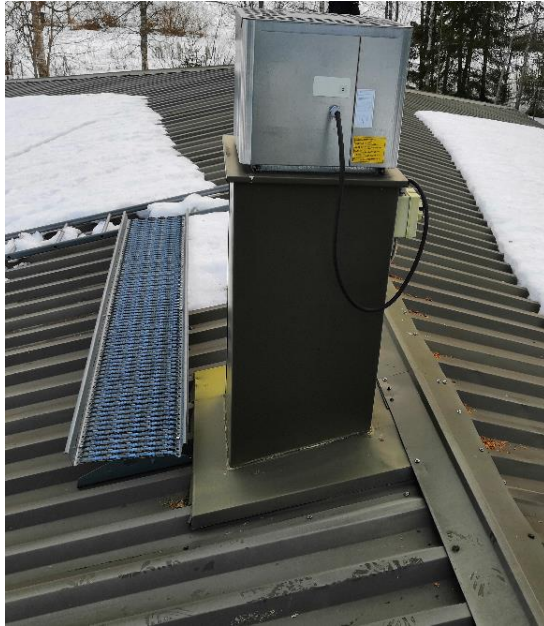
Kuva 47 a ja b. Katolla oli asianmukaiset tikkaat ja huoltotaso. Vesikatteessa oli huippu- puimurin, antennin ja viemärin tuuletusputken läpiviennit. Katteen kiinnitystä on jäl- keenpäin parannettu kateruuveilla.
