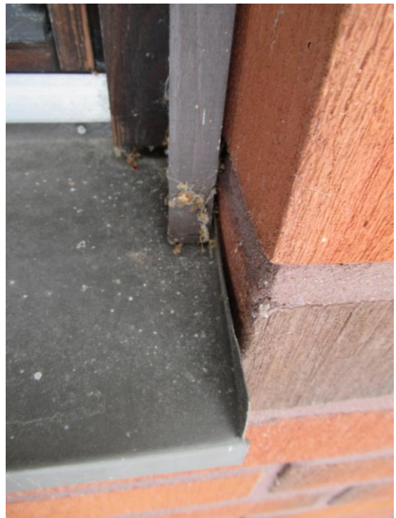
Kuva 30 a ja b. Tiiliverhoiluissa kohdissa ikkunapellityksien kallistukset ovat osittain riittämättömiä eikä ikkunapeltien liittymiä ole tiivistetty. Lisäksi ikkunapeltien naulakiinnitys on puutteellinen.
