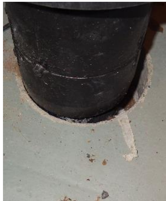
Kuva 16 a ja b. Lämmönjakuhuoneen tekniikkakuilussa yhteys maaperään ja kuilun pohjalla rakennusjätettä. Tarkastusluukusta todettiin tutkimushetkellä selvä ilmavirtaus sisäilmaan päin. Tarkastusluukku ei ole ilmatiivis ja lämmönjakuhuoneessa havaittiin epätiivittä läpivientejä alapohjarakenteessa.
