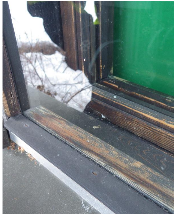
Kuva 29 a ja b. Yleiskuva ikkunasta. Ikkunat ovat yleisesti tyydyttävässä kunnossa. Puunsuoja-aineella käsitellyissä osissa havaittiin haalistumaa ja hilseilyä.
