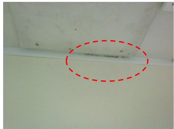
Kuva 58 a ja b. Lämpökamerakuva yläpohjan luukusta (kuva a). Luukun reunoilla havaittiin runsasta ilmavuotoa. Seinällä havaittiin myös ilmavuodon epäpuhtauksien aiheuttamaa tummumista (kuva b).
