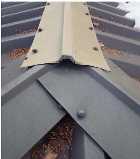
Kuvat 48a ja b. Keskiharjan ja lapeharjojen risteyskohdat epätiivisti toteutettu. Rakennuksen eteläpäädyn liittymää oli tiivistetty jälkikäteen (kuva b).
