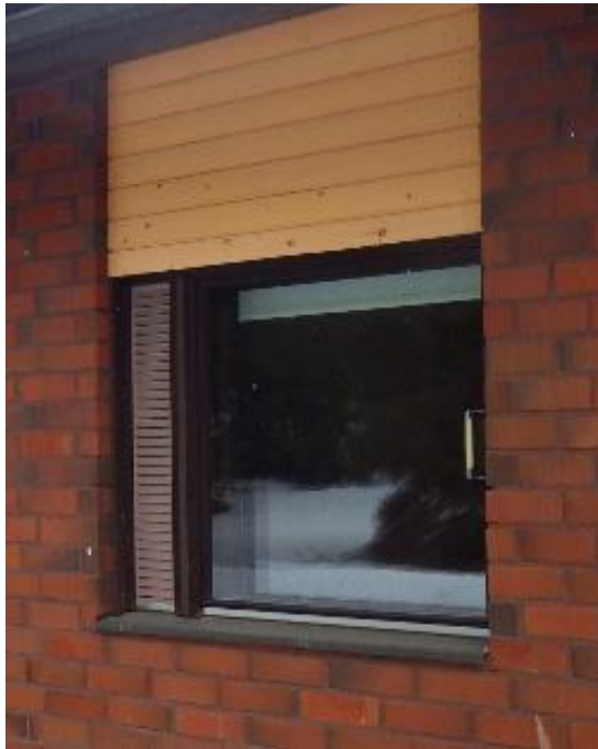
Kuva 29 a ja b. Yleiskuva ikkunasta. Ikkunat ovat yleisesti tyydyttävässä kunnossa. Puunsuoja-aineella käsitellyissä osissa havaittiin haalistumaa ja hilseilyä.
