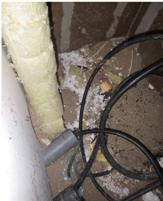
Kuva 16 a ja b. Lämmönjakuhuoneen tekniikkakuilussa yhteys maaperään ja kuilun pohjalla rakennusjätettä. Tarkastusluukusta todettiin tutkimushetkellä selvä ilmavirtaus sisäilmaan päin. Tarkastusluukku ei ole ilmatiivis ja lämmönjakuhuoneessa havaittiin epätiivittä läpivientejä alapohjarakenteessa.
