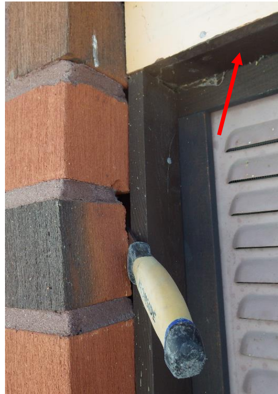
Kuva 28 a ja b. Tiiliverhouksen ja ikkuna-/paneelirakenteen välisissä liitoksissa havaittiin selviä rakoja, joista suora yhteys eristetilaan. Paneeliverhoillut osat ovat tuulettumattomia, koska alapinnan tuuletusväli on tukittu ikkunan pielilaudalla (kuva b, nuoli).
