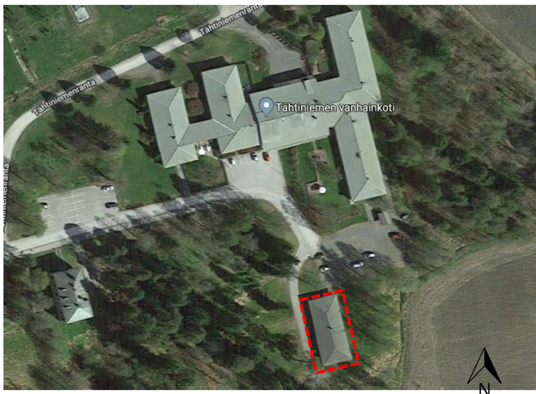
Kuva 1. Ilmakuva tutkimuskohteesta, tutkittava rakennus rajattu katkoviivalla. Rakennus sijaitsee vanhainkodin pihapiirissä pellon reunalla. Pohjoisnuoli kuvan oikeassa alareunassa (Google Maps).
