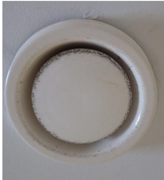
Kuva 66 a ja b. Poistoilmakanavien päätelaitteisiin on kertynyt epäpuhtauksia. Päätelaitteet on kiinnitetty tiukasti kiinni olevilla hakasilla, joka vaikeuttaa huoltotoimenpiteitä.
