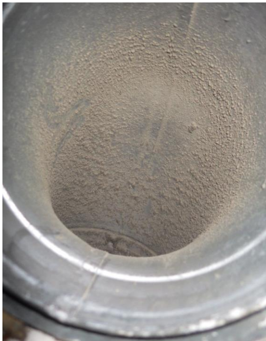
Kuva 67 a ja b. Kanavistossa havaittiin runsaasti epäpuhtauksia. Wc-tilan 028 päätelaitteen irrotuksen yhteydessä havaittiin kanavien irtonainen liitos.
