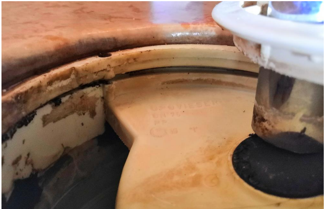
Kuva 41. Pistokoeluoontoisesti tarkastettujen lattiakaivojen kiristysrenkaissa ei havaittu merkittäviä puutteita.
