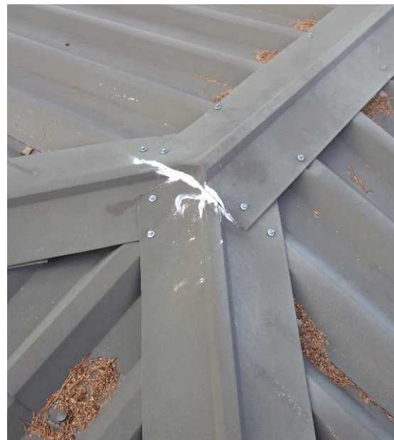
Kuvat 48a ja b. Keskiharjan ja lapeharjojen risteyskohdat epätiivisti toteutettu. Rakennuksen eteläpäädyn liittymää oli tiivistetty jälkikäteen (kuva b).
