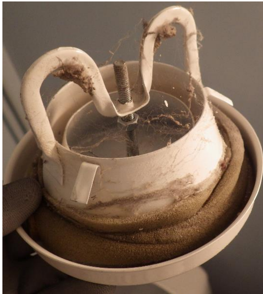
Kuva 66 a ja b. Poistoilmakanavien päätelaitteisiin on kertynyt epäpuhtauksia. Päätelaitteet on kiinnitetty tiukasti kiinni olevilla hakasilla, joka vaikeuttaa huoltotoimenpiteitä.
