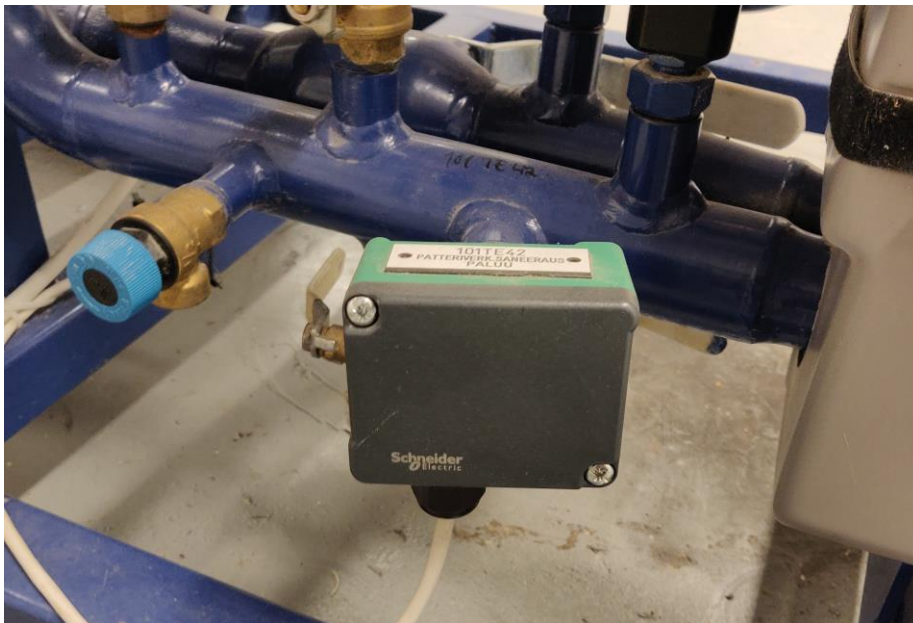
Kuva 4. Patteriverkoston paluuveden lämpötilaa mittaava anturi.
