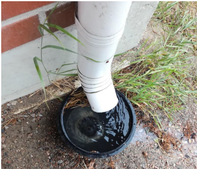
Kuva 14. Tukkeutunut räystäskaivo.
