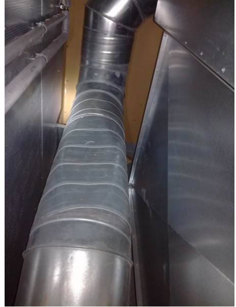
Kuva 13: IV-putki on saanut ison lommon ja vääntynyt neliskanttiseksi päällisin osin
