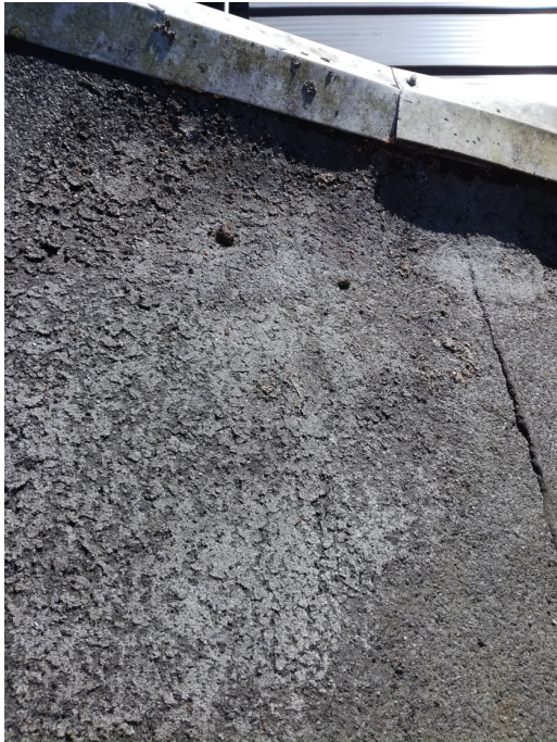
Kuva 9: Huopa on ylittänyt teknisen käyttöikänsä
