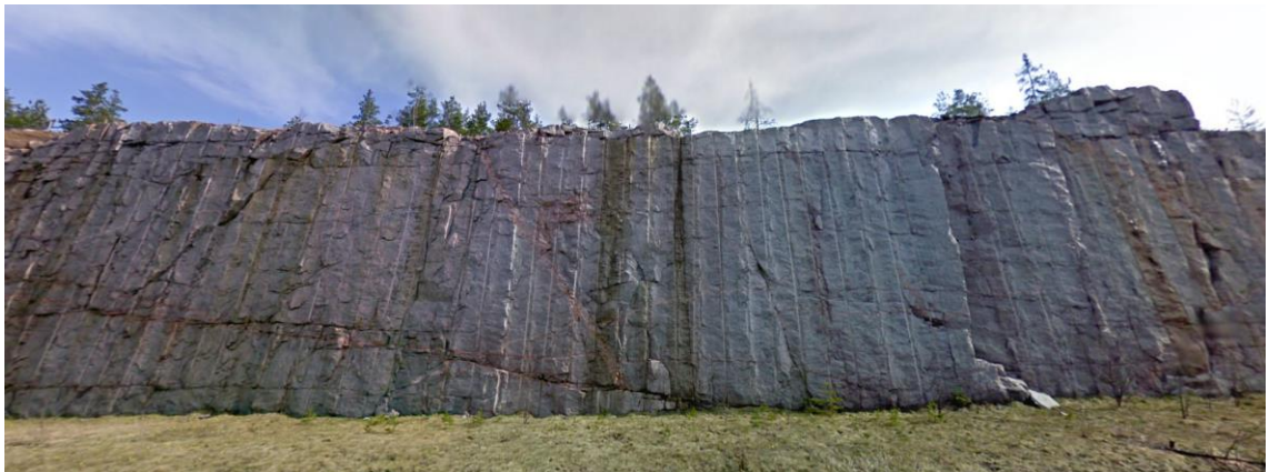
Kuva 4. Tarkkuuslouhittu seinämä [Google Maps.]
