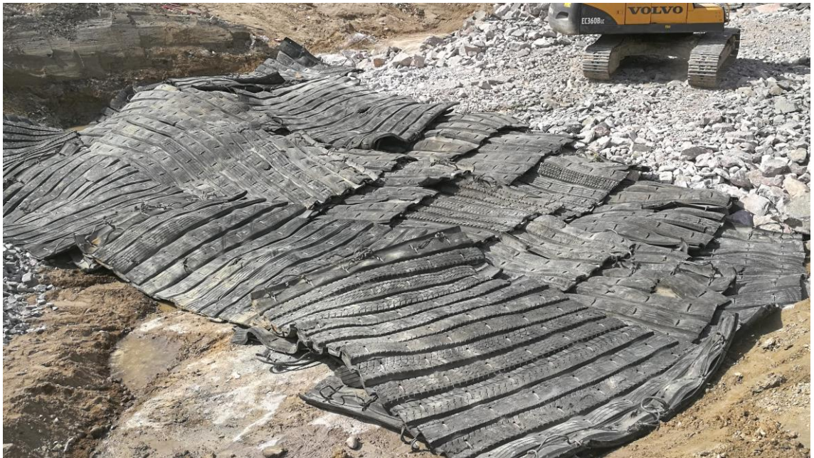
Kuva 16. Kumimatoilla peitetty räjäytyskenttä
