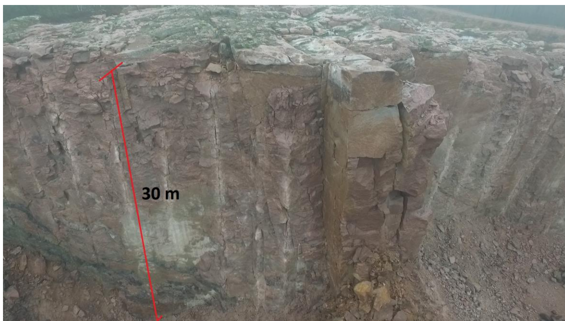
Kuva 18. Kallion keulalle jäänyt kivipaasi
