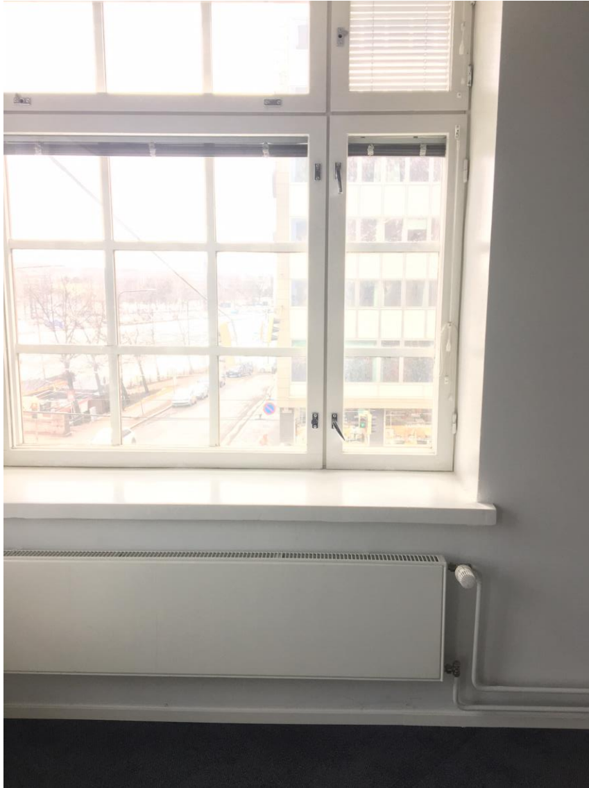
Kuva 7. Maalattu ja valmistunut tiivistysalue.
