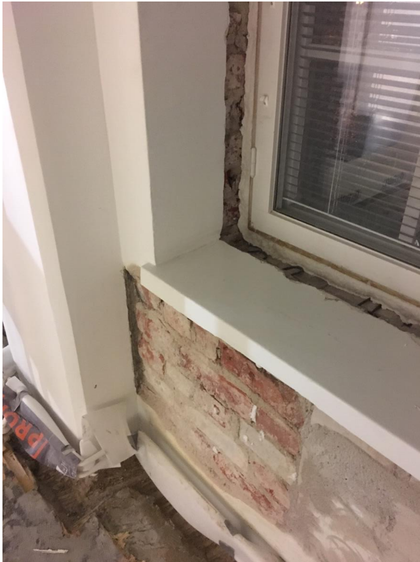
Kuva 6. Suoritettu purku ikkunaliittymien lattian ja seinän liittymien sekä patterintaustan osalta.
