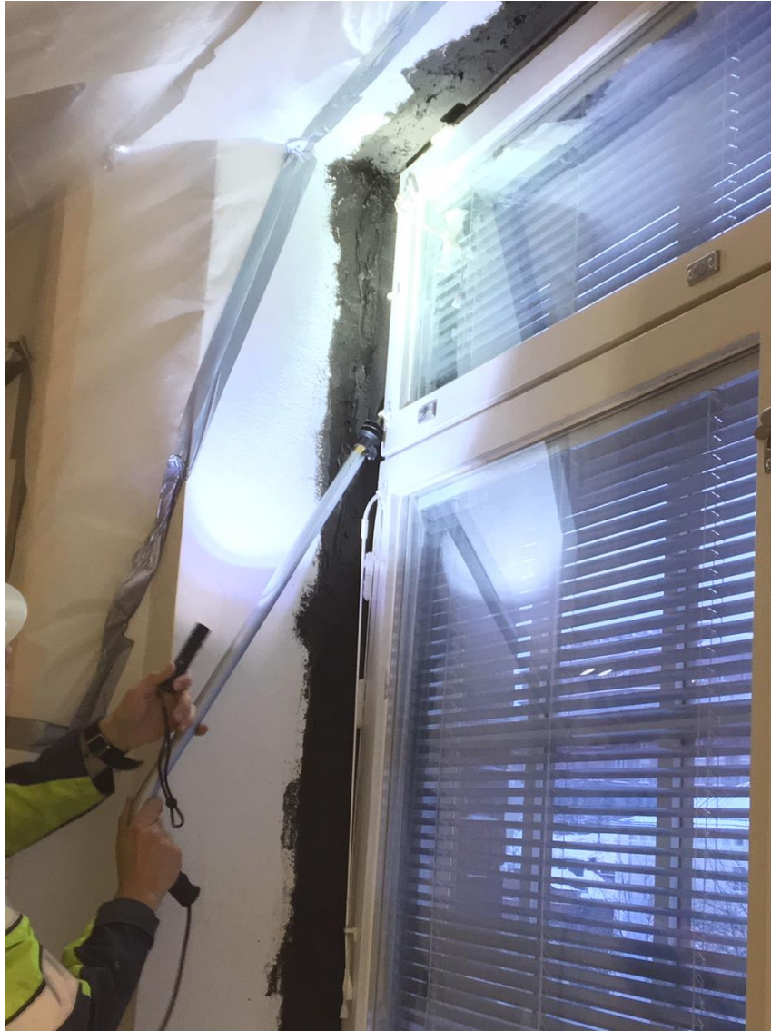
Kuva 4. Merkkiainekokeen mittausvaiheessa mitataan rakenteesta kulkeutuvia ilmavuotoja.
