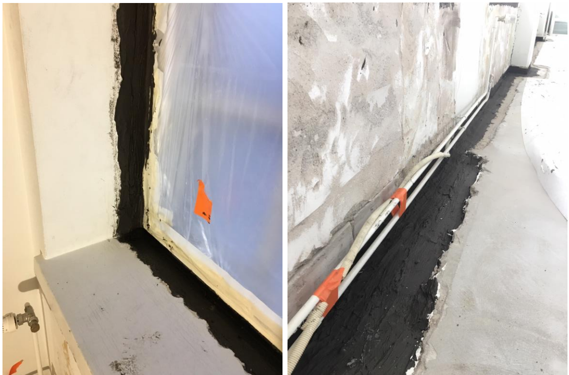
Kuva 2. Vasemmalla tiivistetyt ikkunaliittymät. Oikealla lattian ja seinän liittymän suoritettu tiivistystyö.
