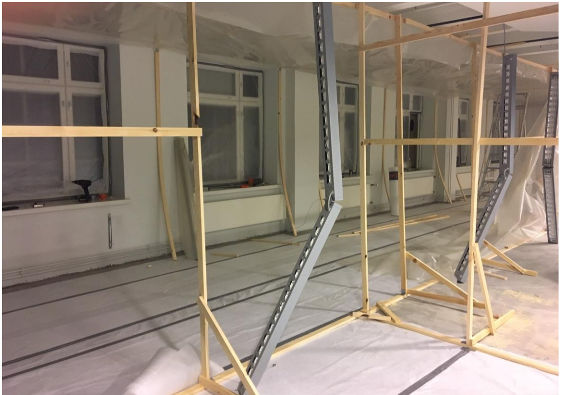
Kuva 5. Suojaseinien ja osastoinnin runko tekeillä.
