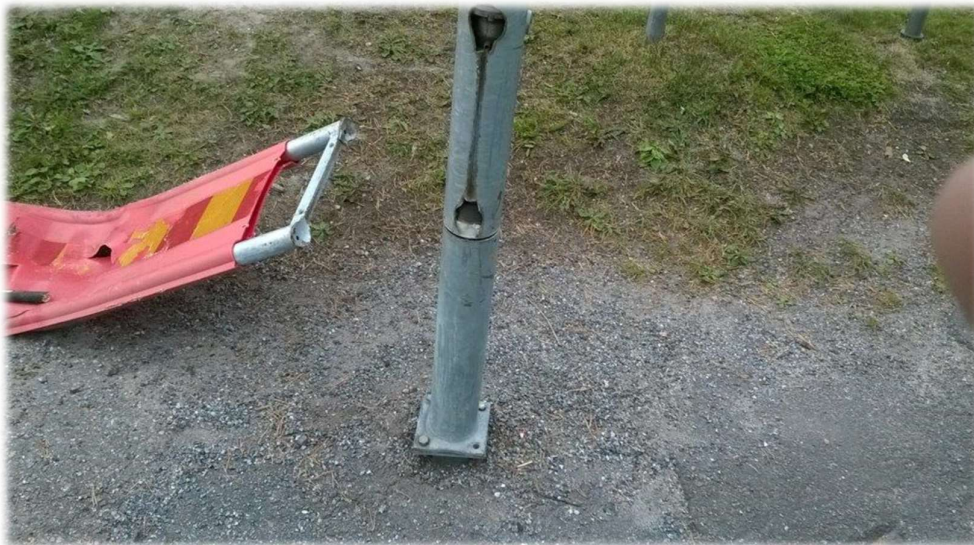
Kuva 27. Kevyenliikenteen portti rikottu (Kuva: Lähteenmäki).
