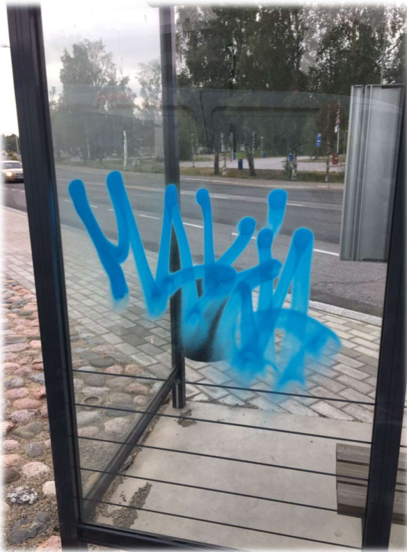
Kuva 22. Linja-autokatoksen lasipaneeli töhritty (Kuva: Etelämäki).
