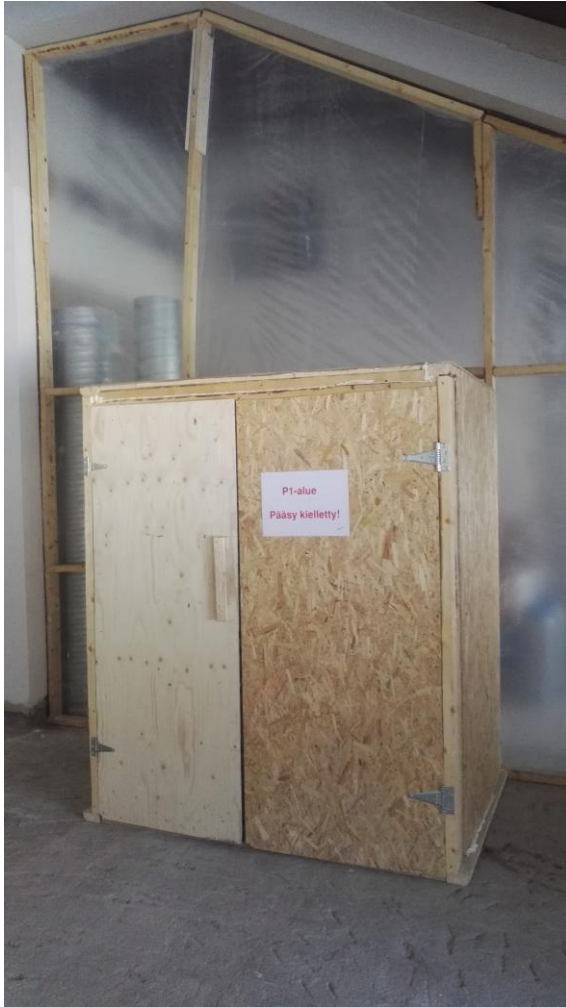
Kuva 5. P1-puhtausluokan ilmanvaihtoasennustöitä varten rakennettu osastointi.
