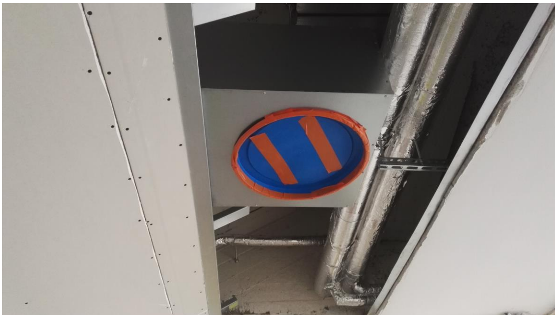
Kuva 7. Ilmanvaihdon päätelaitteen tulppaus.
