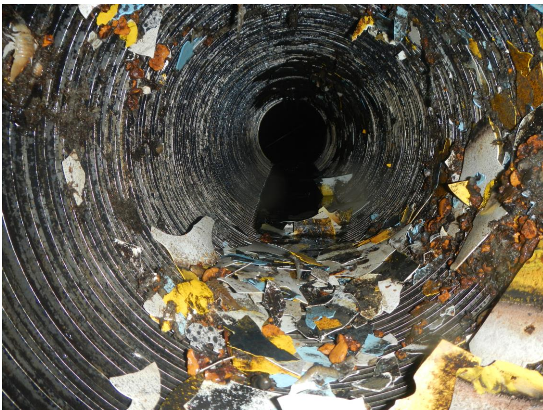
Kuva 14 Merivesilinjan putki kuvattuna sisältäpäin
