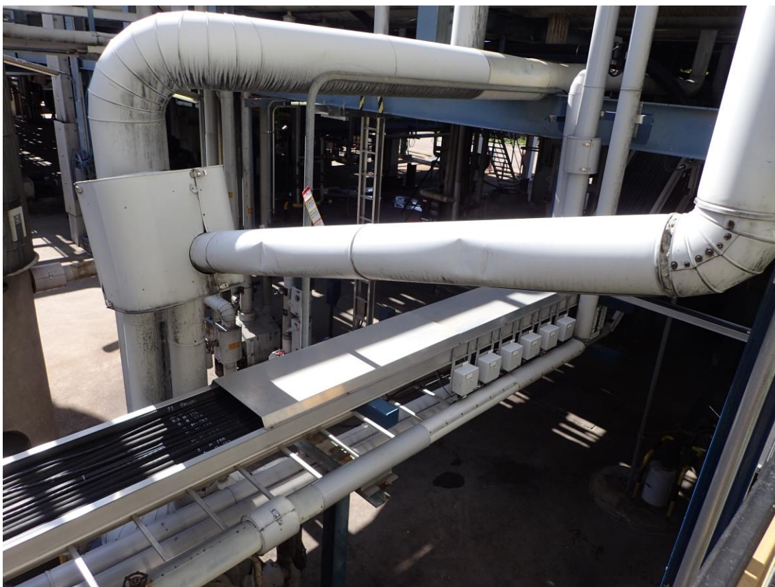
Kuva 15 Puutteellinen lämmöneristys
