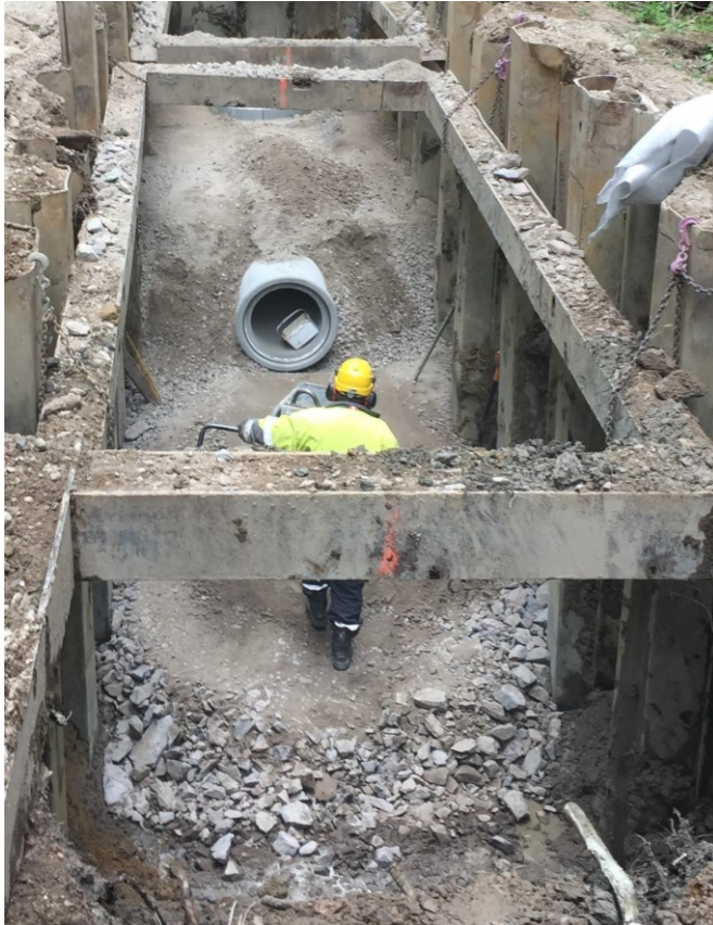
Kuva 9. U-profiilisella pontilla tuettu putkikaivanto.
