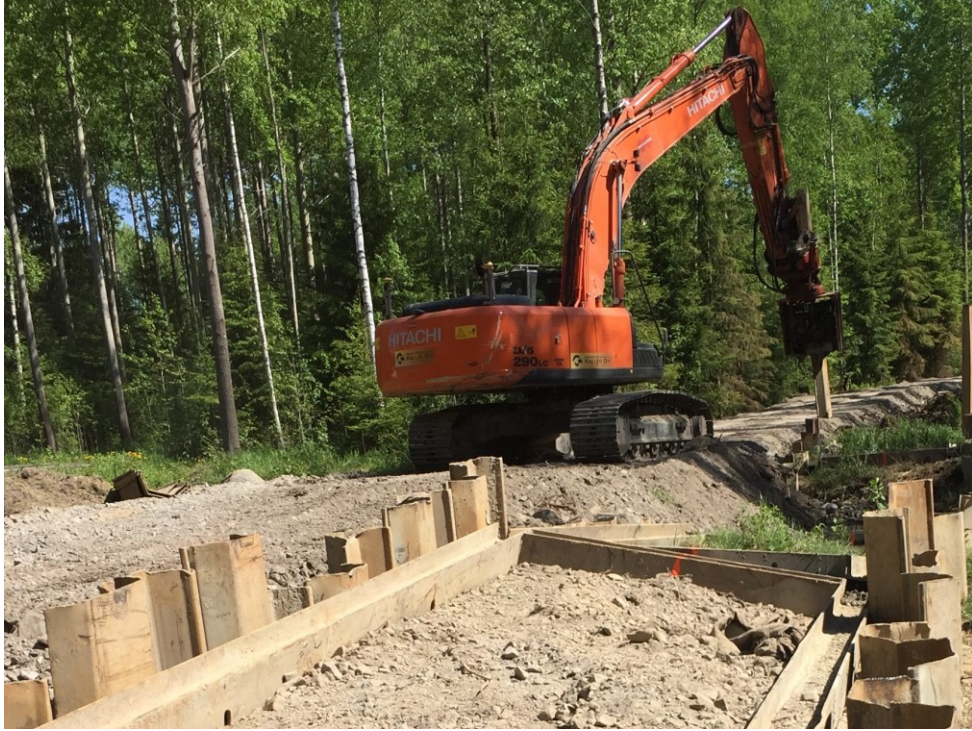
Kuva 11. Ponttien asennusta kaivinkoneeseen kiinnitetyllä ponttivararalla.
