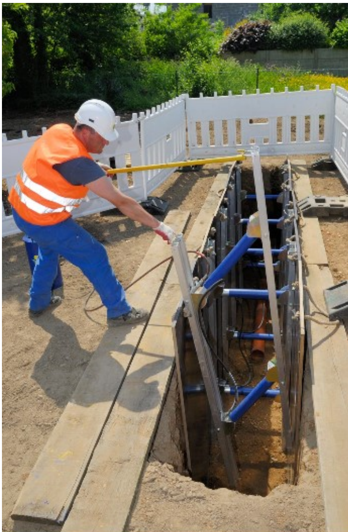
Kuva 3. Tukirungon asennusta ja tuettua kaivantoa. (sbh-shoring.com)
