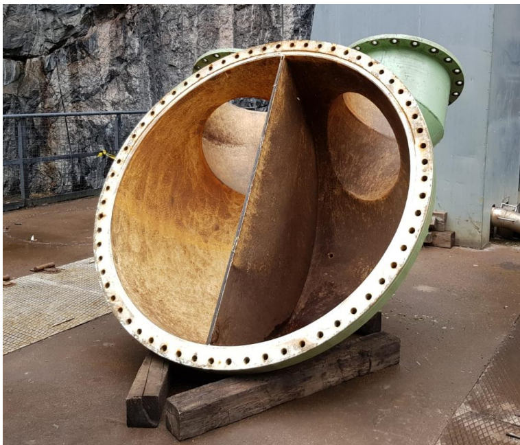
Kuva 12. Jakokammion tarkastuksessa tarkastetaan pinnoitteen kunto.
