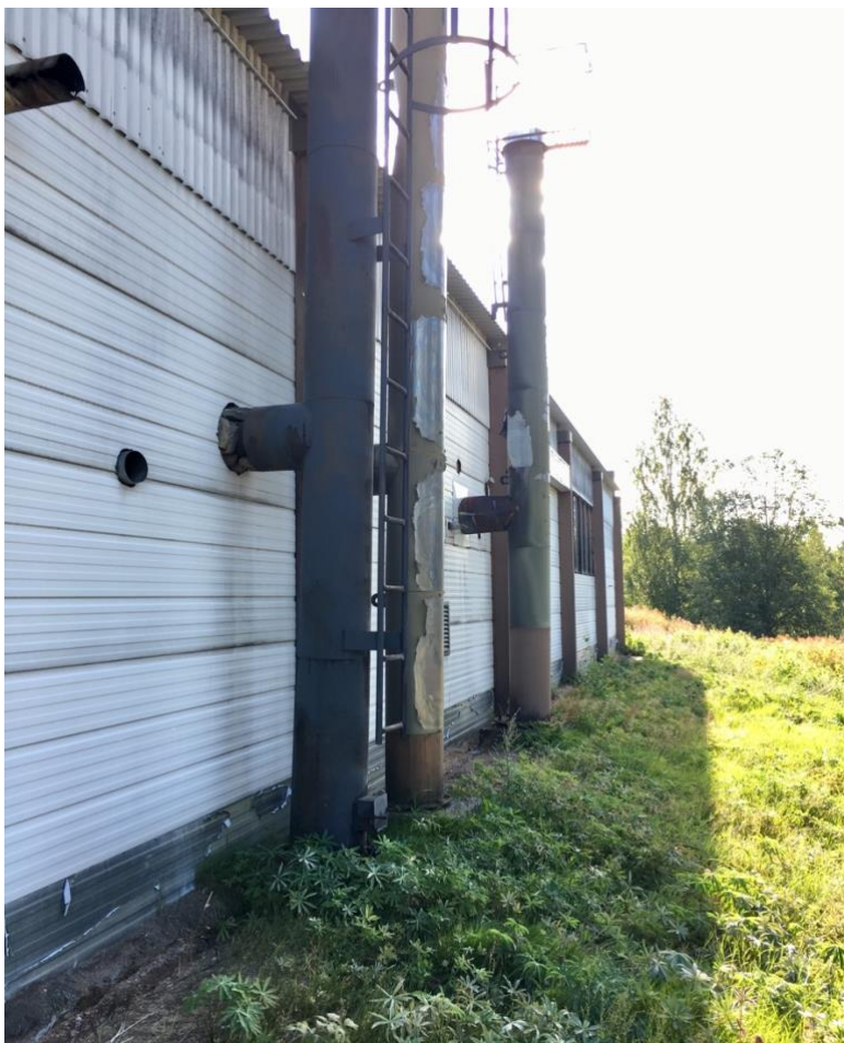
Kuvio 6: Äijäsen Kotileipomo Oy:n leipomorakennuksen piiput.
