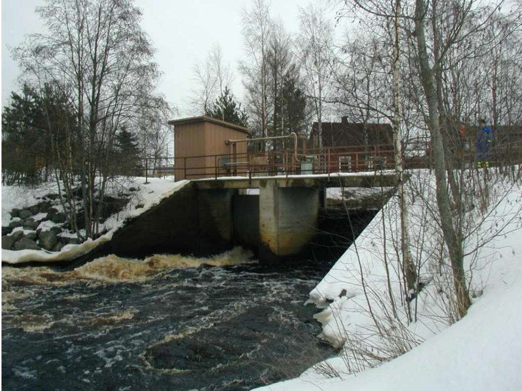
Kuva 7. Kärjenkosken pato kuvattuna alajuoksun puolelta.
