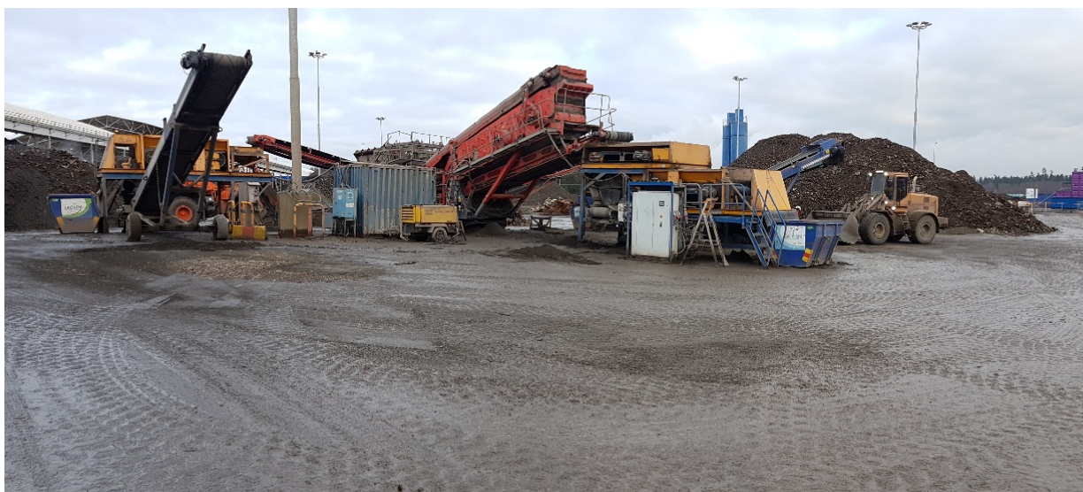
Kuva 8. Kuonankäsittelylaitos Hausjärven teollisuusjätekeskuksessa
