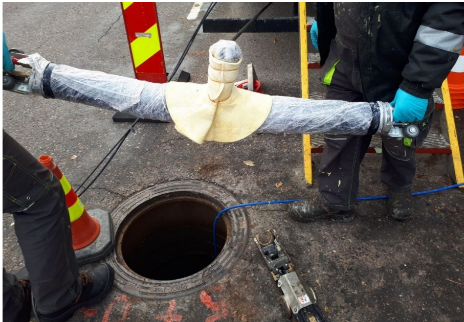
Kuva 10. Hattuprofiili asetettuna asennuksessa apuna käytettävään asennusvaunuun (Leppänen 2018).
