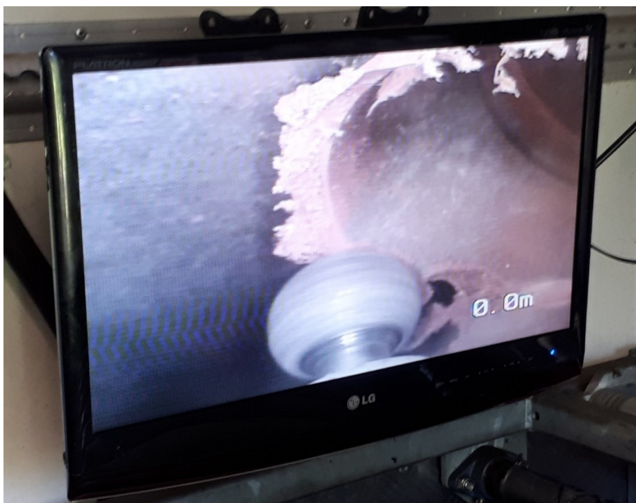
Kuva 9. Porarobotissa olevan kameran kuva putkiliitoksen auki porauksesta (Leppänen 2018).
