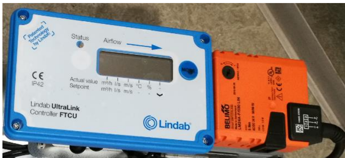
Kuva 12. Näyttölaite sekä peltimoottori on asennettu pienelle hyllylle säätöpellin rungon päälle.
