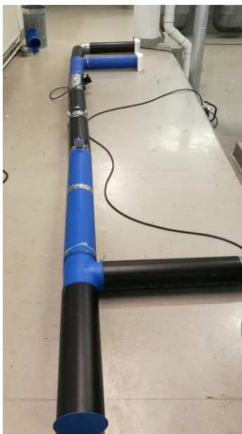
Kuva 7. Ilmamäärien mittauksia varten rakennettu kanavisto.
