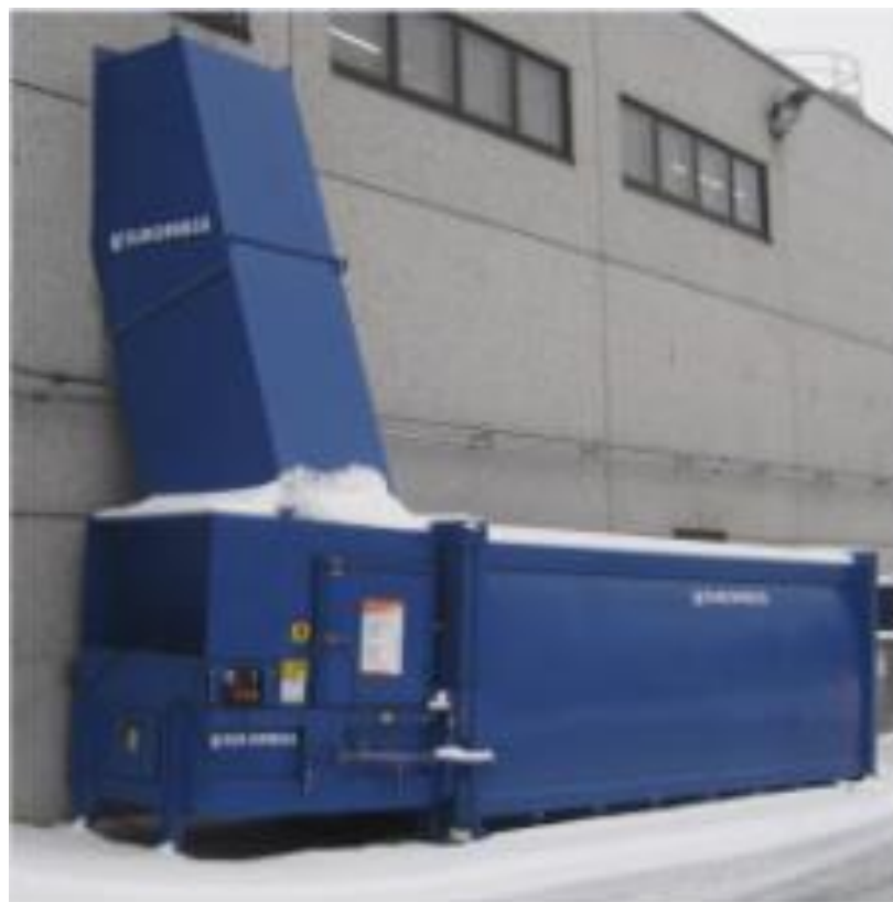
Kuva 2. Jätekuilu sekä puristimella varustettu jätelava (Europress 2018)
