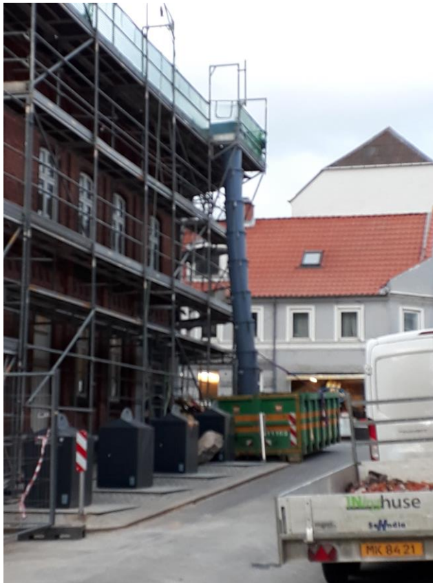
Kuva 1. Jätekuilu ja roskalava Tanskassa Horsensin kaupungissa.
