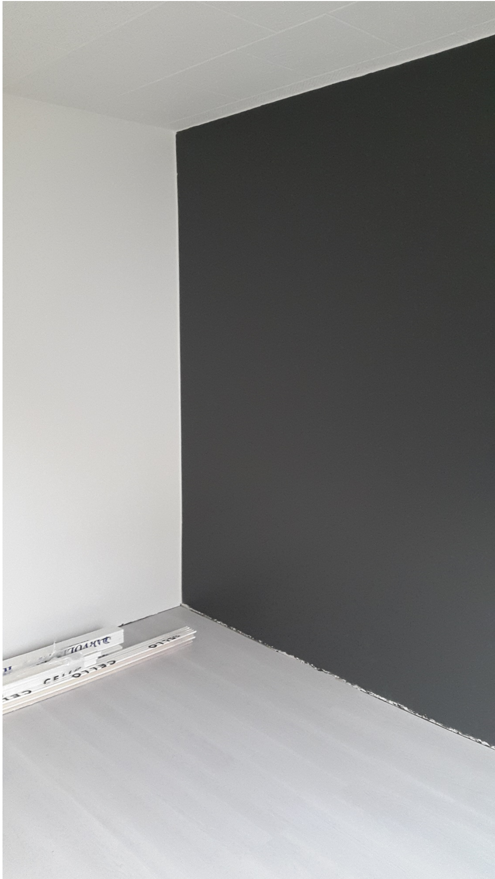
Kuva 6. Lankkulattian päälle asennettiin vinyylimatto.
