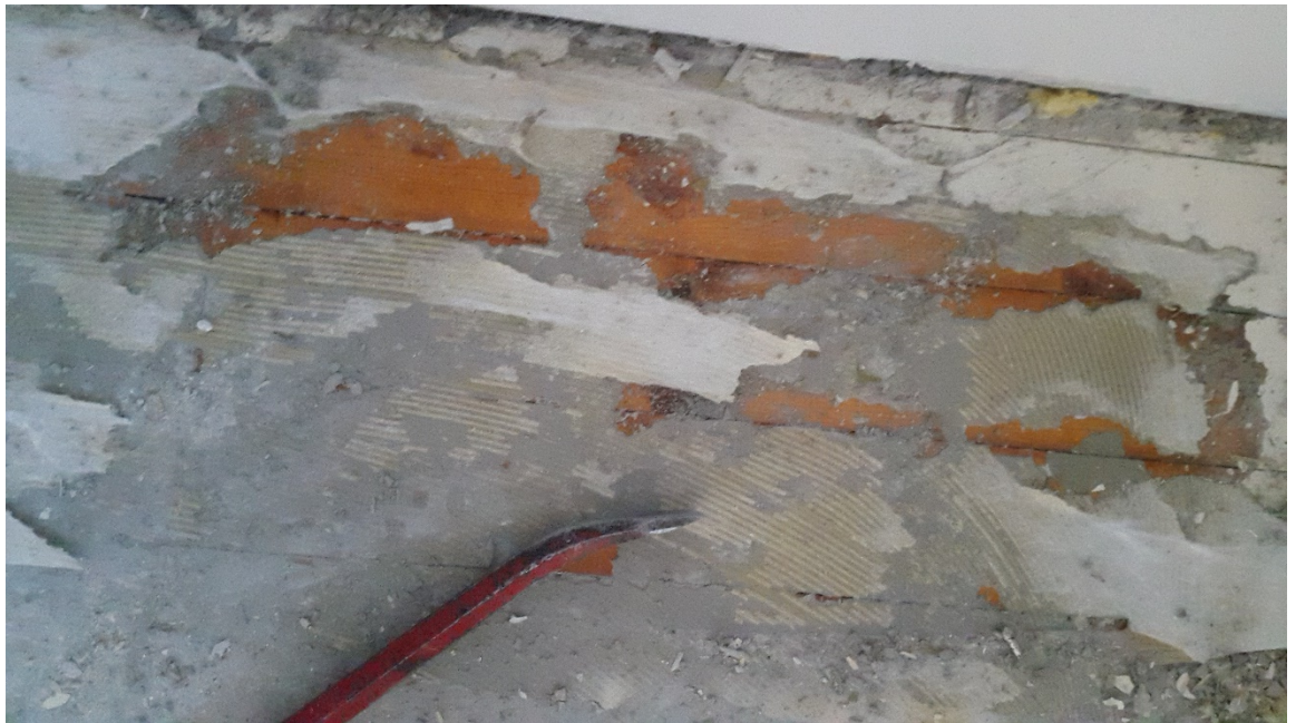
Kuva 5. Lankkulattian päälle oli asennettu aikaisemmin linoleumimatto.
