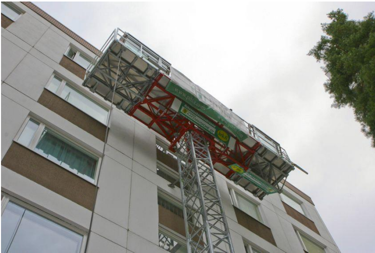
Mastolava Scancelimber SC4000 julkisivutöissä (Kuva: HRK konevuokraamot (21) )
