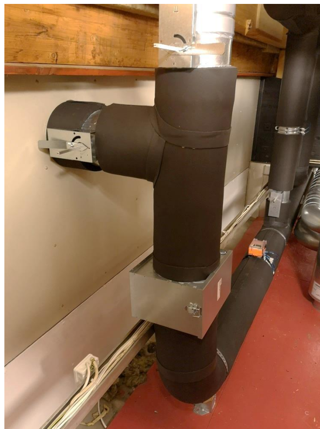
Figur 25. Uteluftsidan med möjligheten att använda utomhusluft eller luft från maskinhallen. Filterlåda samt blandningskanalen i bakgrunden.
