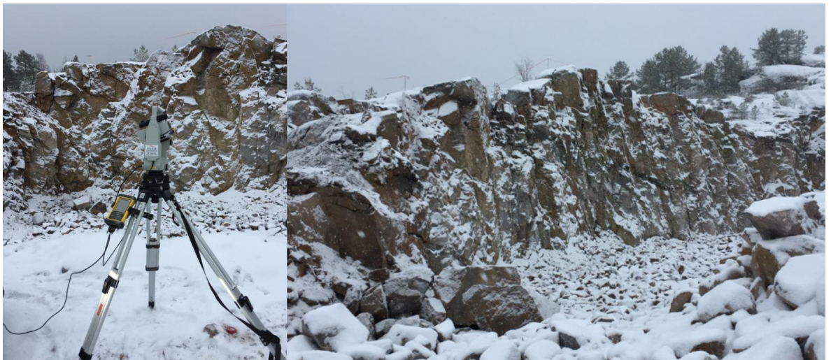
KUVA 18. Rintauksen skannaus (YIT työmaa, Salo).
