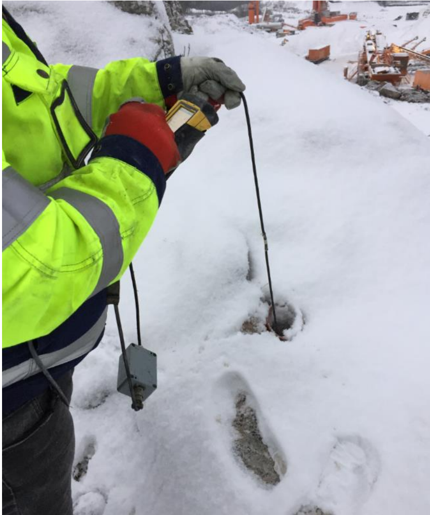
Kuva 4. Manuaalinen reikäsuoruuksmittaus käynnissä (YIT työmaa, Salo).
