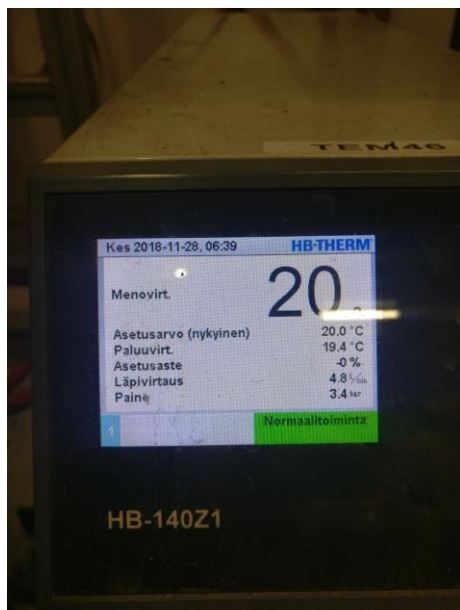
Kuva 17 Virtaus ennen puhdistusta
