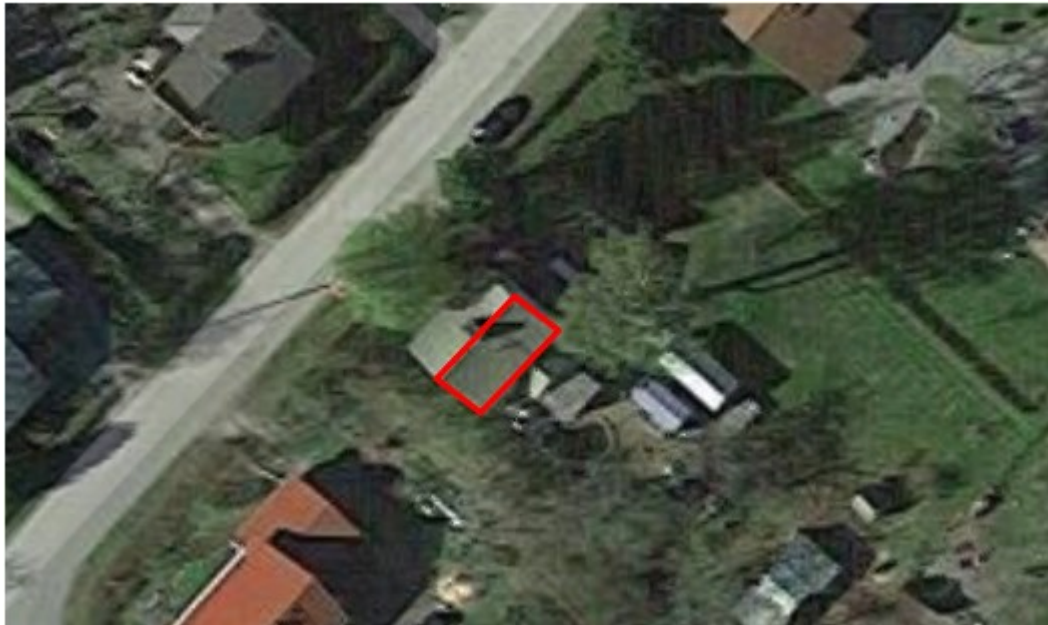
KUVA 9. Kohderakennus ilmasta ja paneelien asennuspaikka (Google Maps, 2019)
